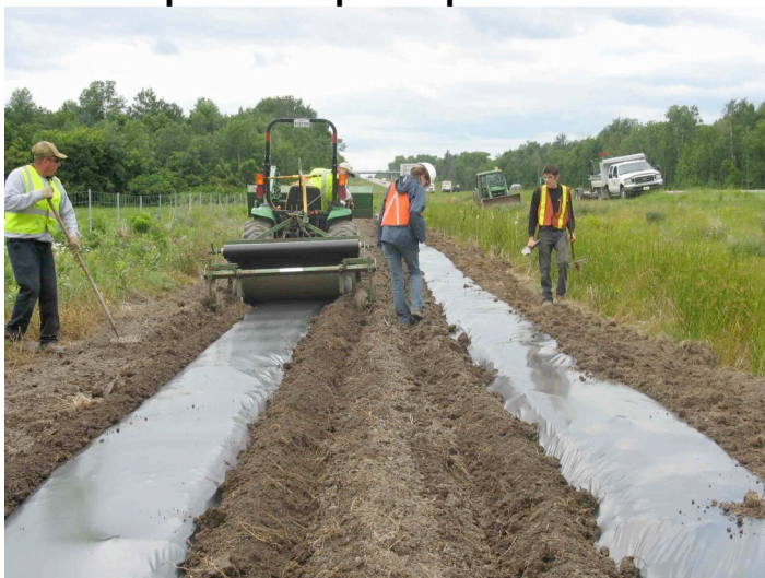
Dérouleuse de plastique sur l'autoroute 50 à Lachute
