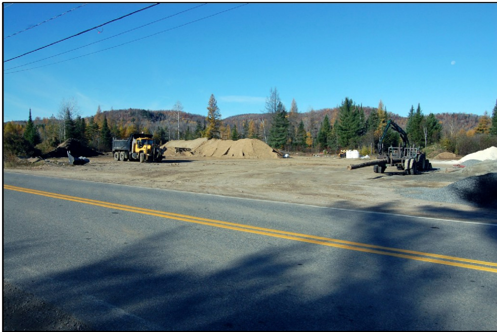
Photo 18 Projet n° 154-95-1386 (site B), sablière située du côté nord de l'emprise, entre les km 6+678 à 6+751, secteur 6, vers le nord (PATR08N4-178)
