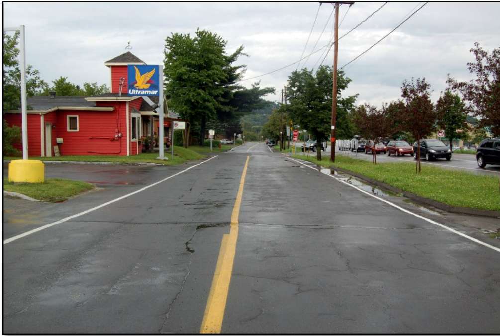
Photo 29 Projet n° 154-06-0640, environnement du secteur 7, à partir du km 0 + 220, vers l'est (PATR08N4-97)
