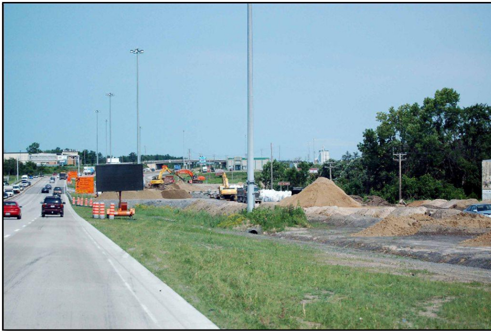
Photo 3 Projet n° 154-06-0315, environnement du secteur 1, travaux en cours, vers le nord-est (PATR08N4-05)
