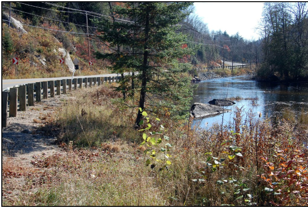
Photo 7 Projet n° 154-95-1385 (site A), vue de la rivière Maskinongé qui longe la limite sud de l'emprise, secteur 1, entre les 2+810 et 3+040, km 2+930, vers l'est (PATR08N4-137)
