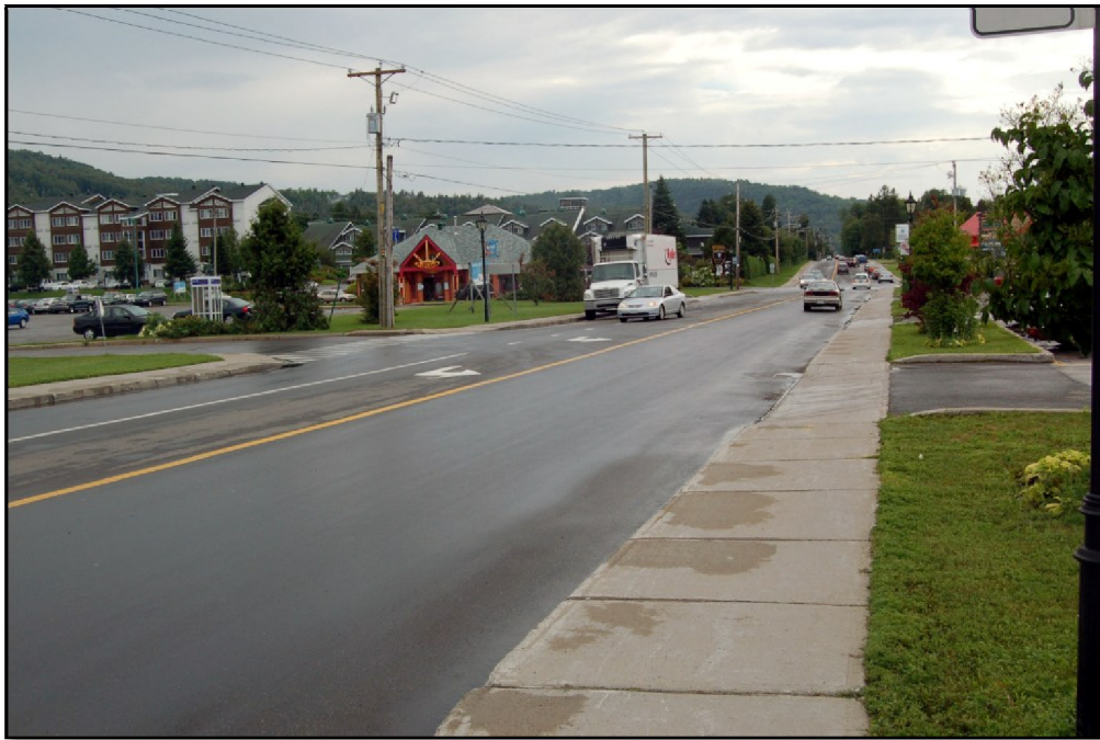
Photo 27 Projet n° 154-06-0640, environnement du secteur 5, à partir du km 30 + 250, vers le sud-ouest (PATR08N4-101)
