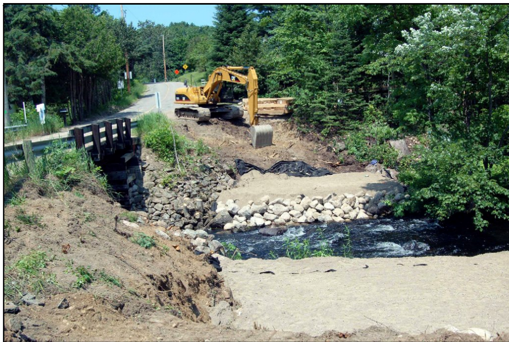
Photo 2 Projet n° 154-04-0926, environnement du secteur 1, travaux en cours, vers le nord-ouest (PATR08N2-11)
