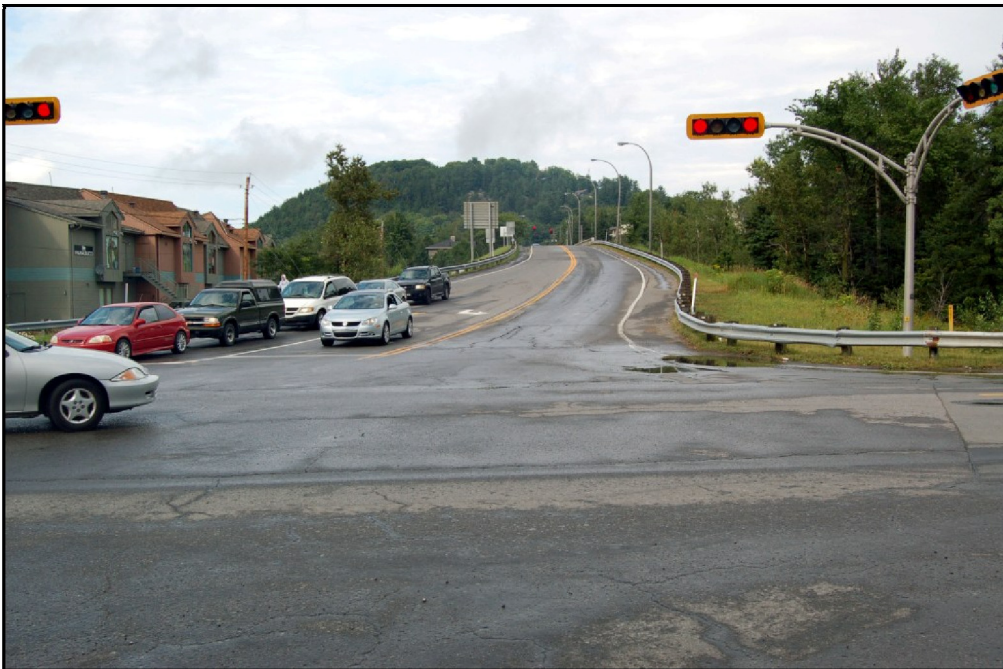
Photo 28 Projet n° 154-06-0640, environnement du secteur 6, à partir du km 10 + 110, vers l'est (PATR08N4-104)
