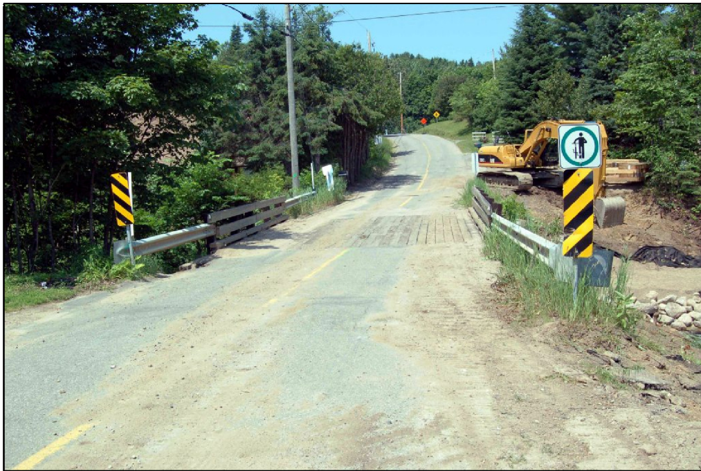
Photo 1 Projet n° 154-04-0926, environnement du secteur 1, vers le nord-ouest (PATR08N2-12)
