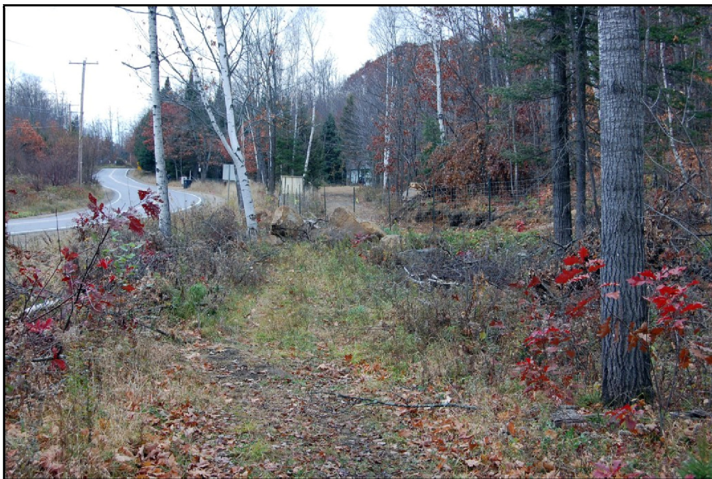
Photo 8 Projet n° 154-95-1385 (site A), vue de l'emprise, secteur 2, km 3+800 à 4+000, vers l'ouest (PATR08N4-145)
