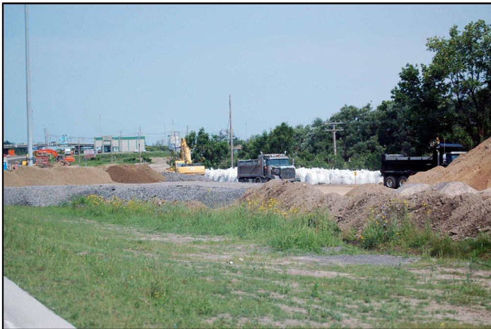
Photo 4 Projet n° 154-06-0315, environnement du secteur 1, travaux en cours, vers le nord-est (PATR08N4-06)
