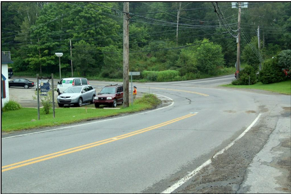
Photo 31 Projet n° 154-02-1521, environnement du secteur 1, à partir du km 0 + 226, vers le sud-ouest (PATR08N4-78)
