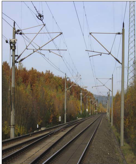
Mât avec dispositif de tensionnement
