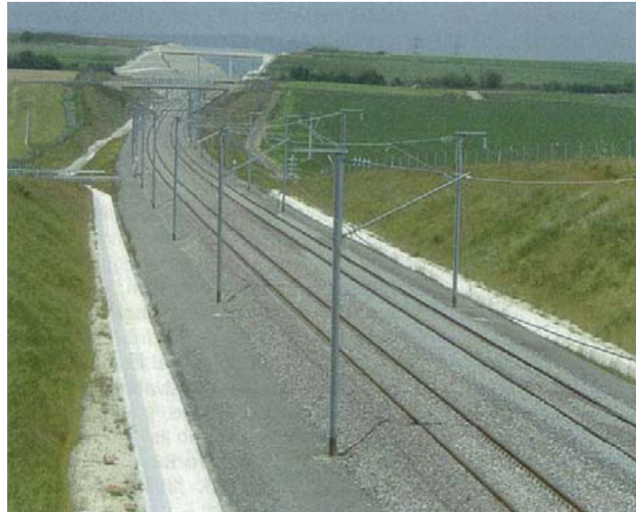
FIGURE 9 : Voie sur Ballast, TGV Est (Rießberger, [9])
