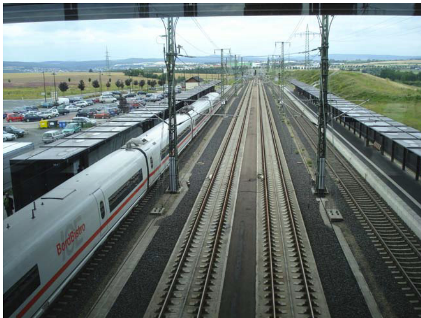
FIGURE 29 : Voies principales et voies d'embarquement à la gare Limburg sur la voie haute vitesse Francfort-Cologne
