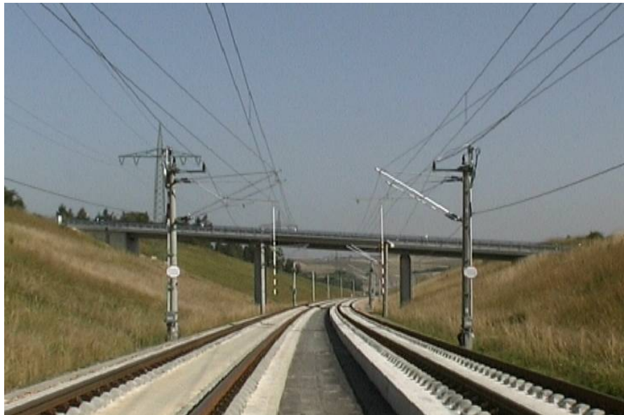
FIGURE 2-2 : CATÉNAIRE DE LA LIGNE HAUTE VITESSE COLOGNE-FRANCFORT
