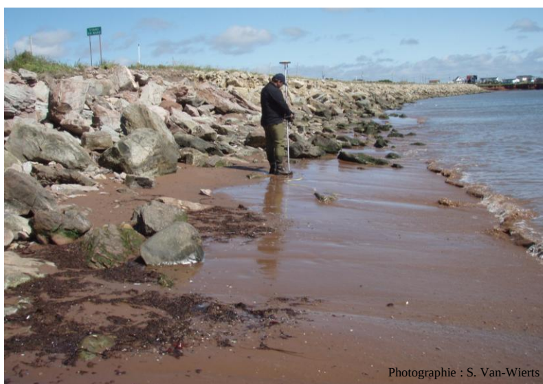
Figure 85. Portion de côte enrochée au nord du secteur de la Martinique
