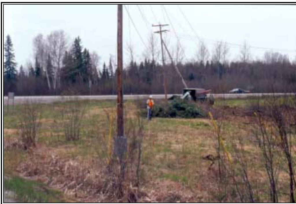
Photo 7 Projet 20-6871-9301, route 395, côté ouest (secteur 5), vue d'ensemble de la zone sondée, vers le sud-ouest.
