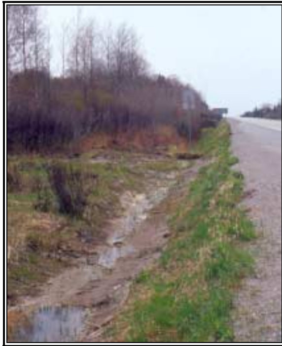
Photo 3 Projet 20-6871-9301, route 117, côté sud, vue d'ensemble du secteur sondé (1) à partir du km 2 + 000, vers l'ouest.
