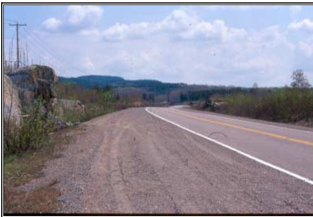
Photo 11 Projet 20-6800-9507, secteur IV, vue d'ensemble, vers l'est.
