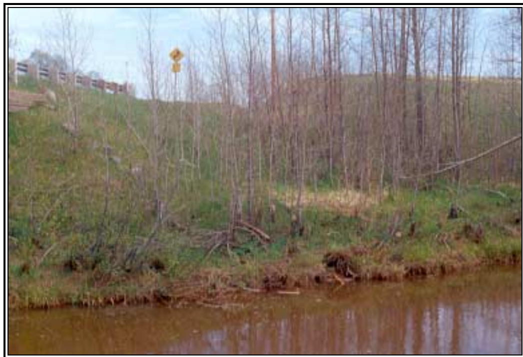
Photo 20 Projet 20-5874-9904, pont de rivière Desméloizes, côté sud de la route, rive est de la rivière, vue d'ensemble de la zone, prise de la rive ouest.
