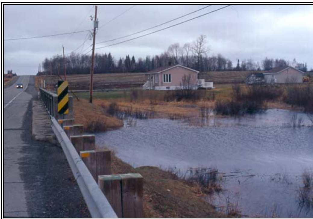
Photo 1 Projet 20-6871-9306, route 111, pont de la rivière Lacorne, rive est, vers le sud.
