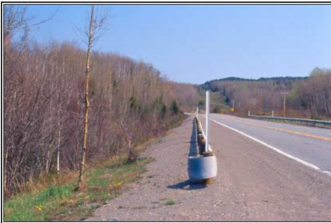
Photo 14 Projet 20-6800-9507, secteur II, côté ouest de la route 101, zone d'inspection visuelle, vers le nord.
