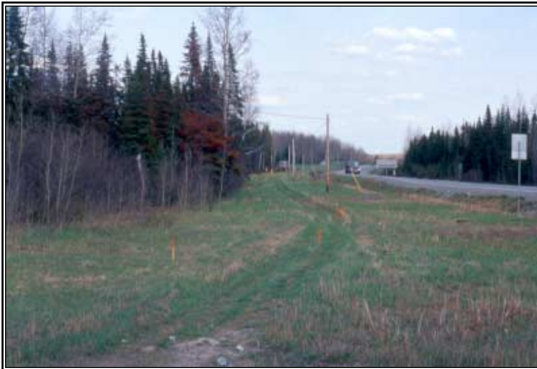
Photo 5 Projet 20-6871-9301, route 117, côté nord, vue d'ensemble du secteur sondé (4), à partir du km 2 + 300, vers le sud-ouest.
