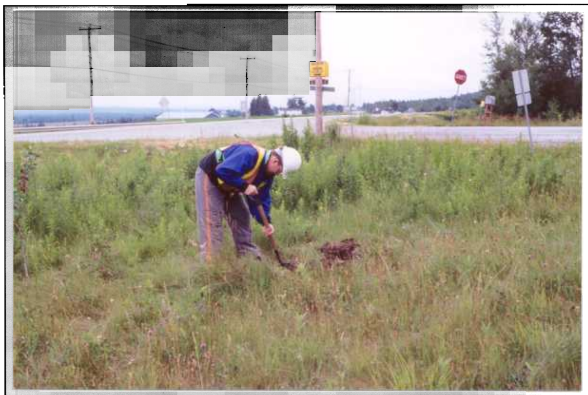
Photo 6: Projet 20-6100-9896, route 112 ouest et chemin Gosford, secteur 2, vue générale, équipe au travail, vue vers l'ouest (O)
