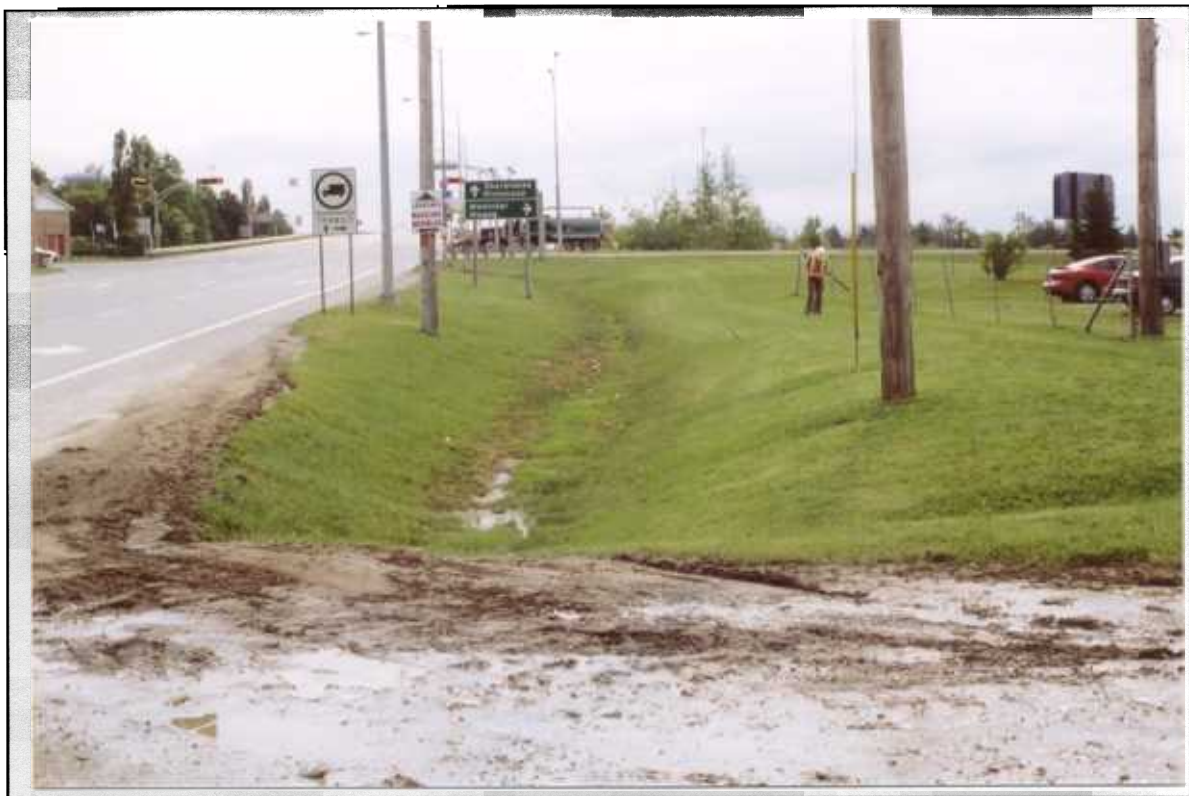
Photo 7: Projet 20-6173-8801-A, route 220 et chemins Dion et Godin, secteur 1, vue générale du km 6 + 820 portion sud, vers l'est (E)
