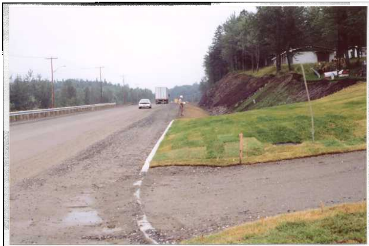
Photo 9: Projet 20-6173-9506-A, route 141 et chemins St-Pierre et Cotnoir, secteur 1, vue générale du km 3 + 180, côté nord, vers l'ouest (O)
