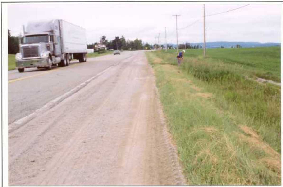
Photo 5: Projet 20-6100-9896, route 112 ouest et chemin Gosford, secteur 1, vue générale à partir du km 6 + 920 côté sud, vers le nord-est (NE)
