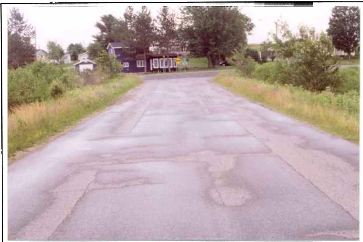
Photo 11: Projet 20-6174-8302-B, route 216 sud et chemin 5 e rang, secteur 1, vue générale à partir du km 2 + 550, vers le nord (N)
