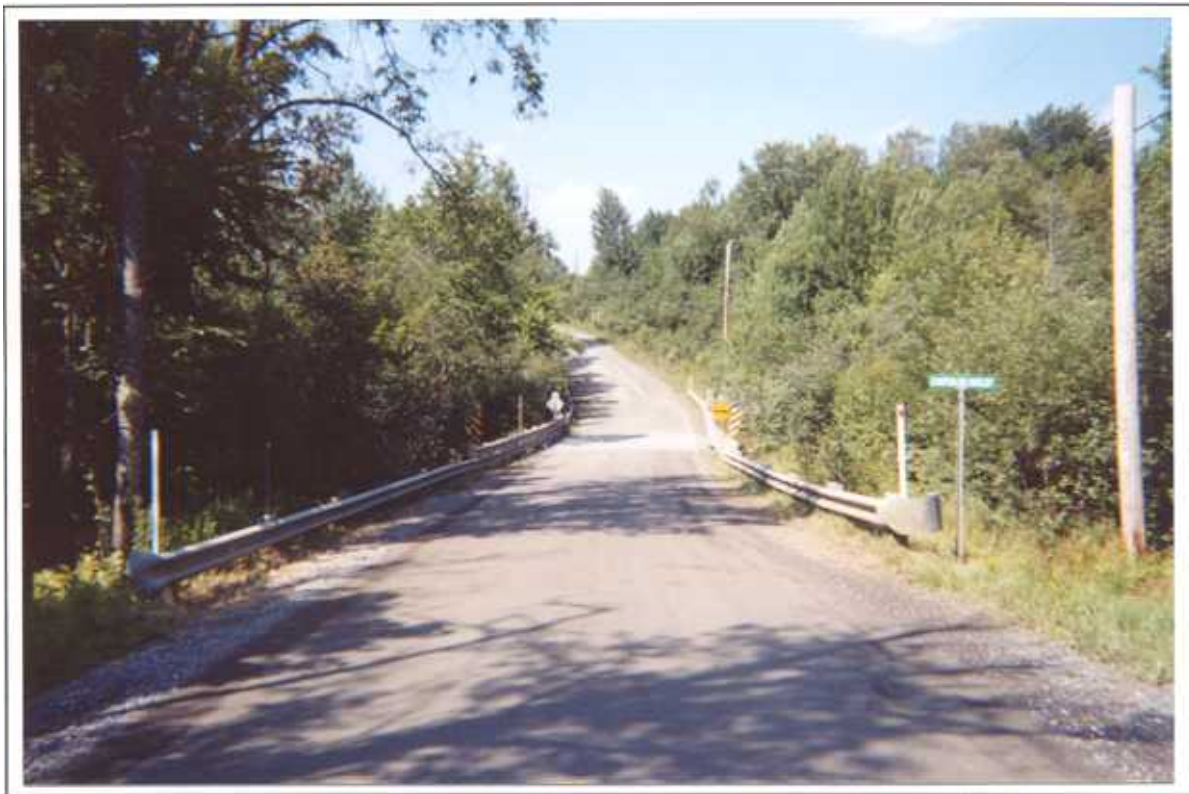
Photo 3: Projet 20-6100-9880, chemin du Lac, secteur 1, vue générale vers le nord (N)
