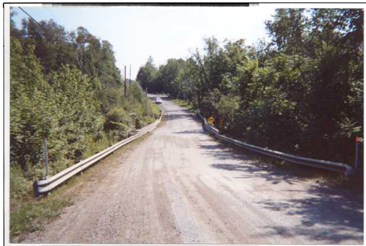
Photo 4: Projet 20-6100-9880, chemin du Lac, secteur 2, vue générale vers le sud (S)
