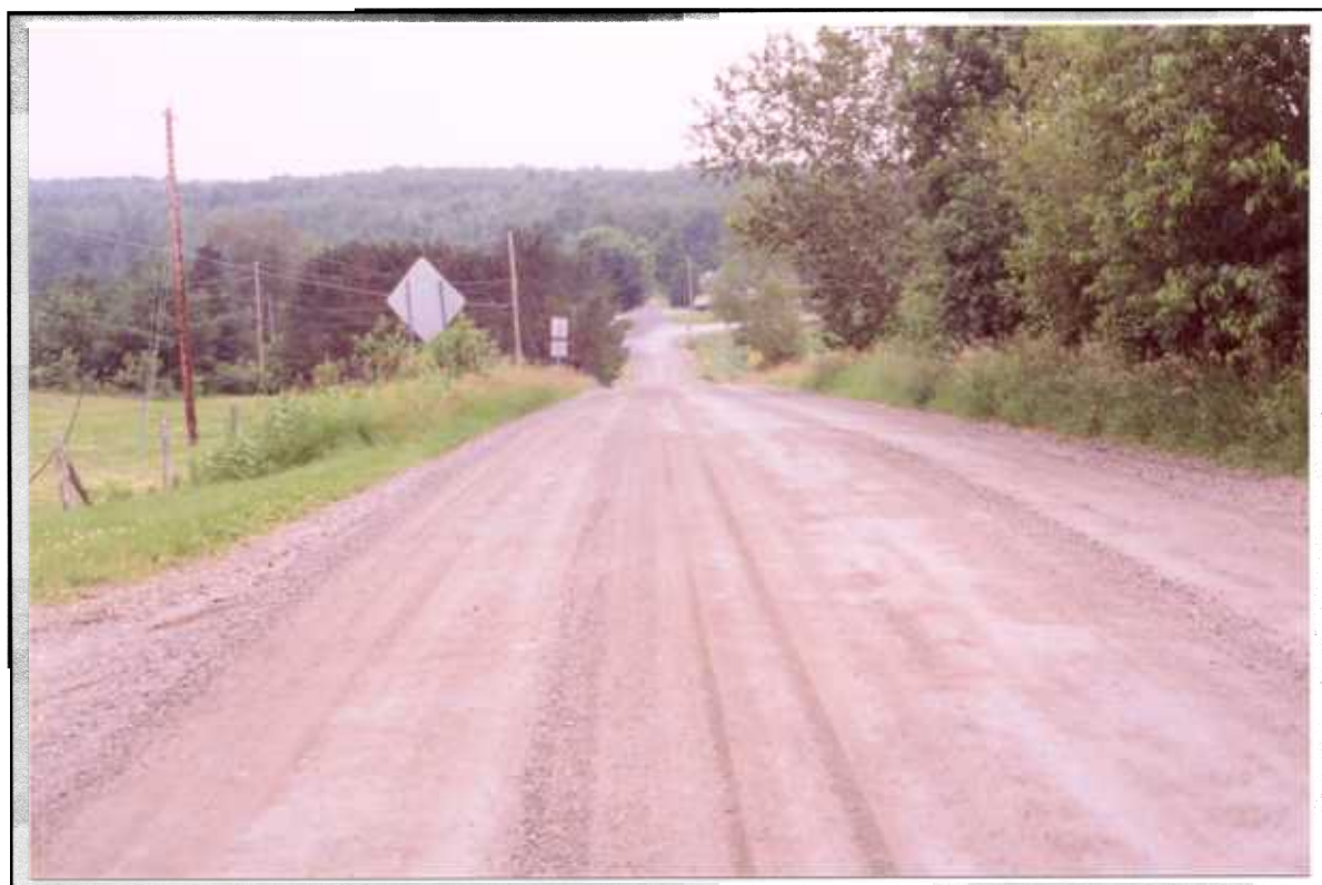
Photo 12: Projet 20-6174-8302-B, route 216 sud et chemin 5 e rang, secteur 4, vue générale à partir du km 2 + 800, vers le sud-est (SE)
