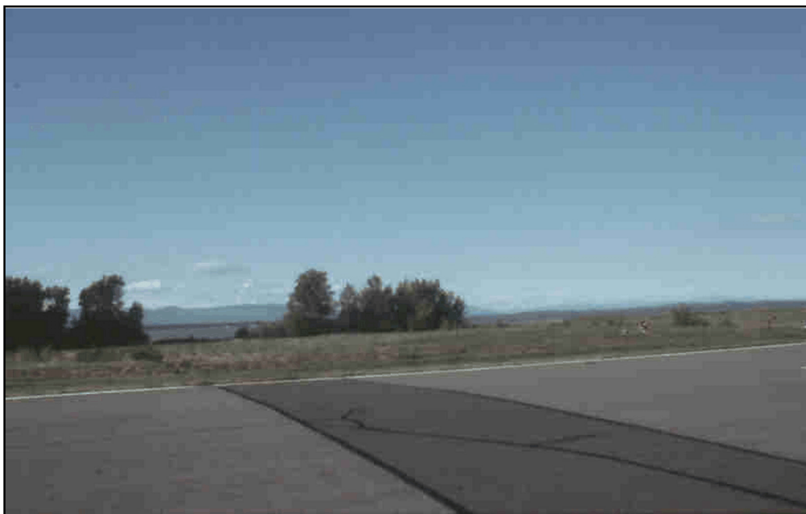
Photo 3 Projet 60-3473-9205, secteur 3, vue générale à partir du côté sud de la piste, vers le nord (N)
