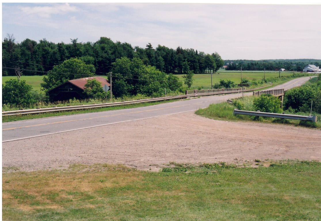
Photo 4 Projet 20-3274-9918, chemin Saint-Albert, 1+100-1+000 (SE)
