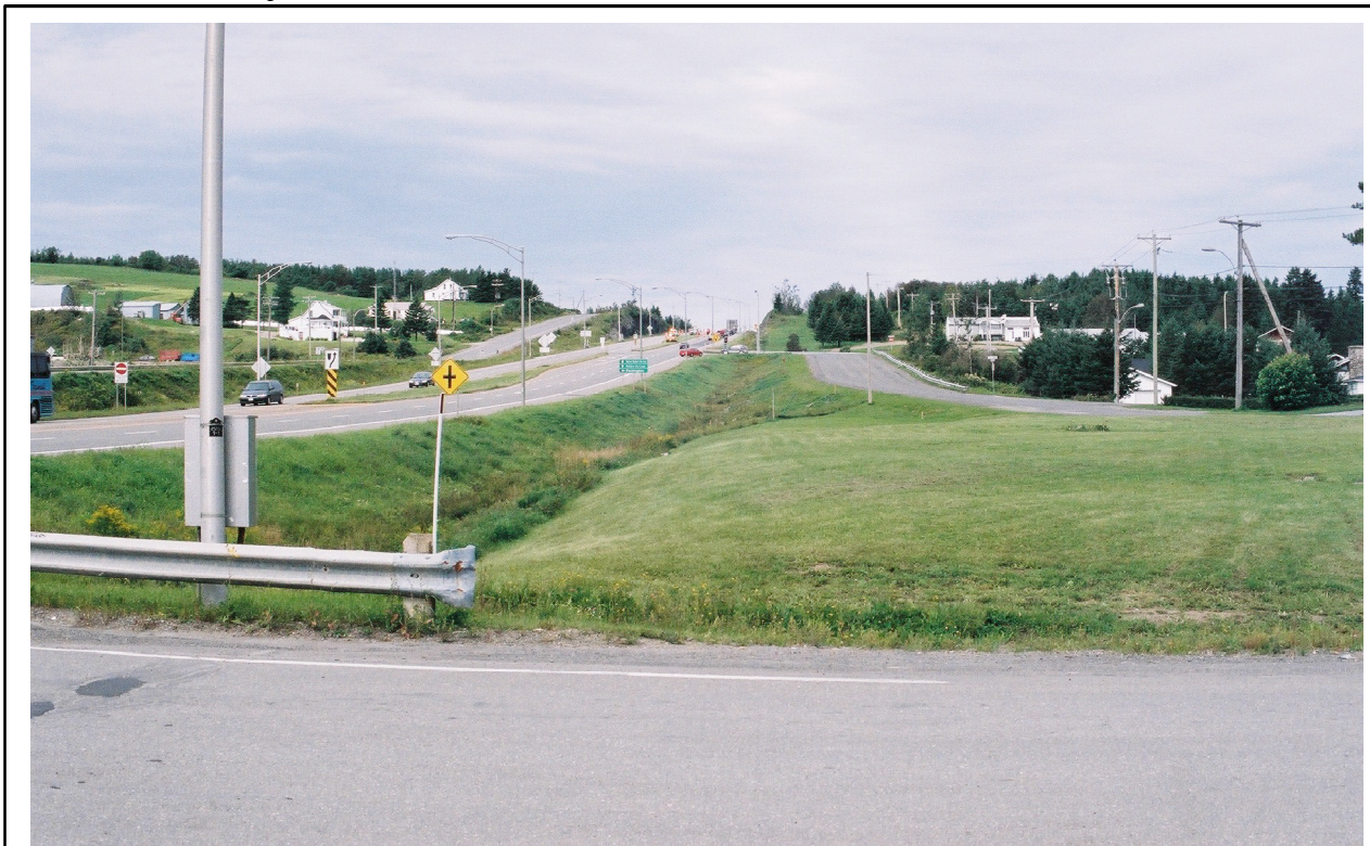
Photo 5 Projet 20-3372-9806, route 185, km 10+800-10+500, secteur 1 (NE)
