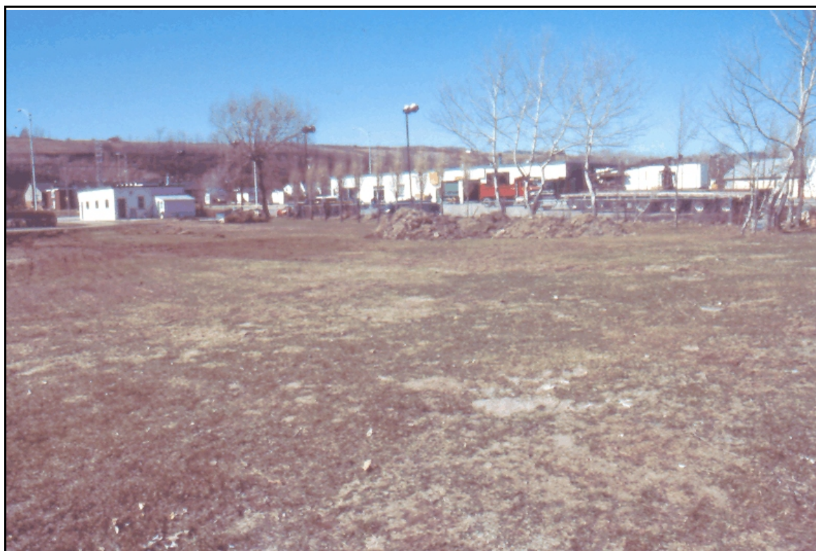
Photo 6 Projet 20-3972-9129 (phase 4), route 138, secteur 4, vue générale à partir du km 20+279, vers le nord-nord-est (NNE)
