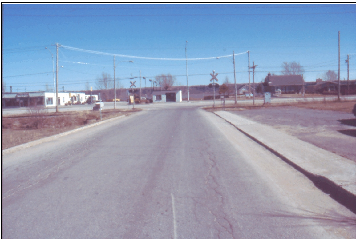
Photo 5 Projet 20-3972-9129 (phase 4), route 138, secteurs 3 et 4, vue générale à partir du km 20+129 , vers le sud (S)
