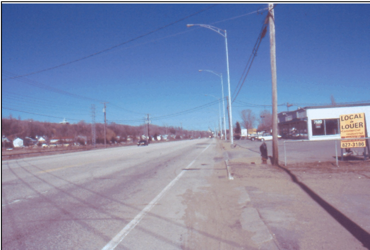
Photo 4 Projet 20-3972-9127(phase 4), route 138, secteur 2, vue générale à partir du km 12+100, vers l'est (E)
