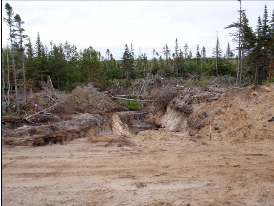
Photo 7 : Sols sablonneux excavés pour l'aménagement du chemin menant à la carrière, ruisseau en arrière-plan, secteur n° 1, km 39 + 740, direction est (154-95-0429-08-NUM2-41)
