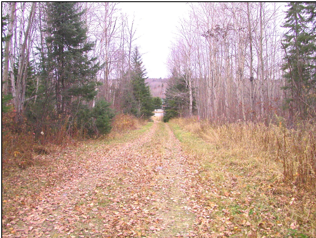
Photo 2 Projet 20-6872-9807, emprise du chemin de déviation (ancien Chemin Saint-Clément), vue vers le nord.
