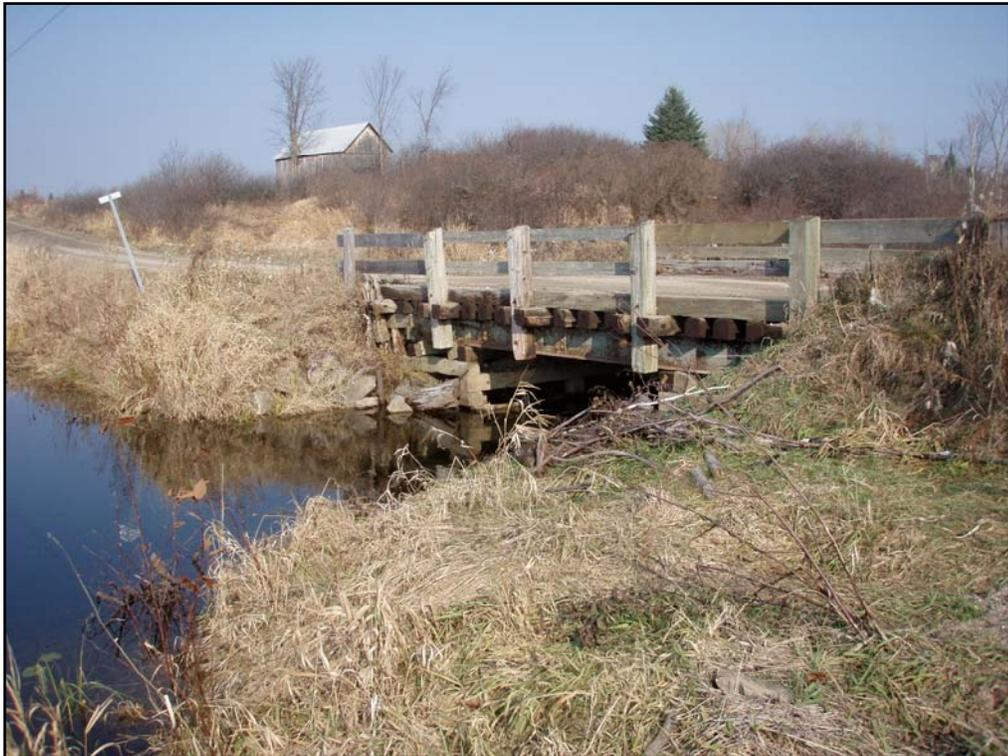
Photo 5 : Culées et remblais du pont n° P-08845 à reconstruire, direction nord (154-93-2111-08-NUM1-4)
