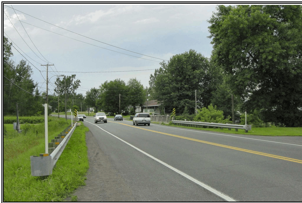
Photo 10 Projet 20-5372-9805, route 132, secteur 2, vue générale vers le nord-ouest (NO)
