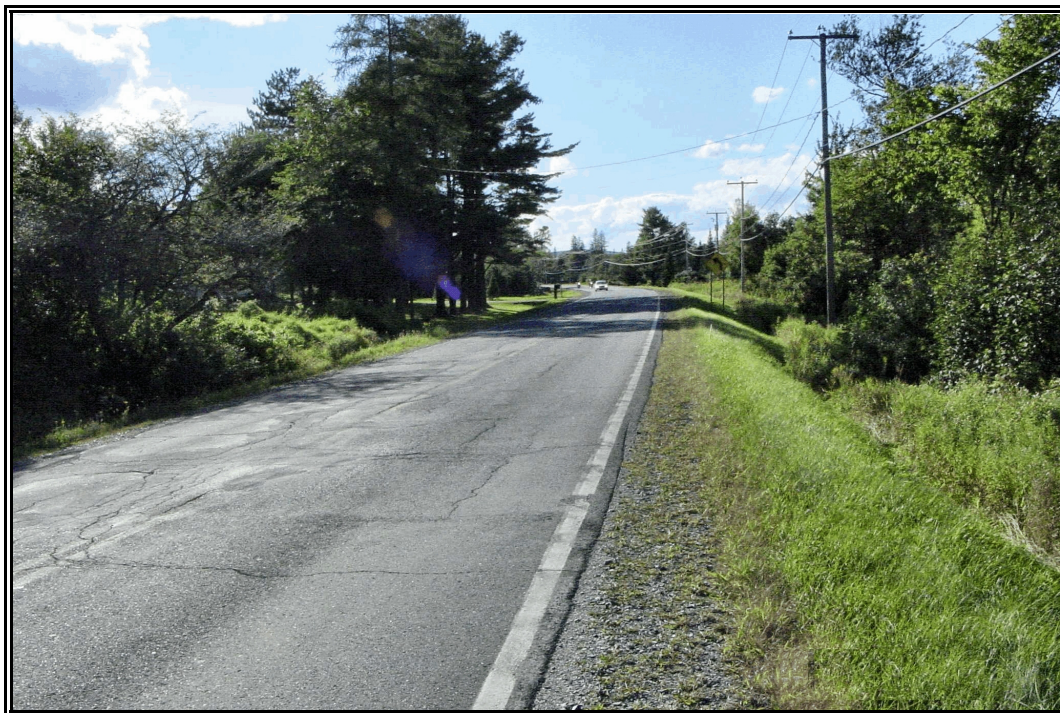
Photo 17 Projet 20-5373-9320, route 243, secteur 4, vue générale du ponceau 4, vers le nord-ouest (NO)
