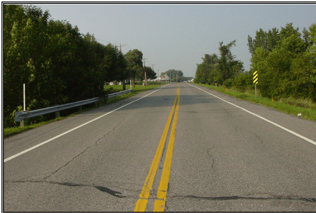
Photo 2 Projet 20-5371-0069, route 223, secteur 2, ponceau B, km 7+514, vue vers le nord-est (NE)
