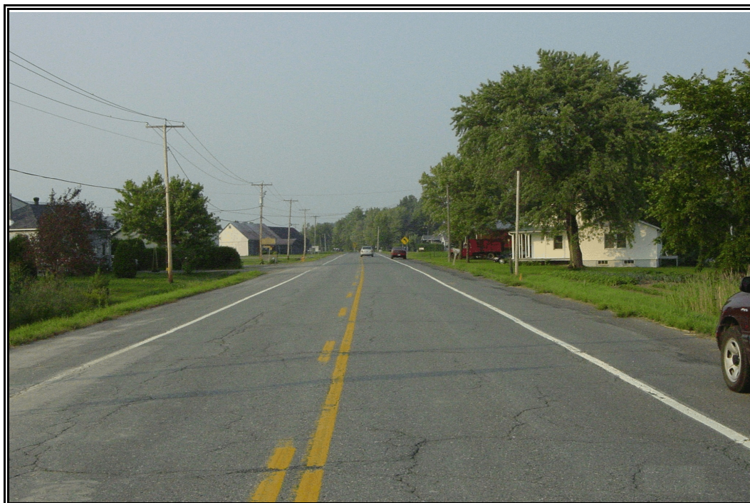
Photo 8 Projet 20-5371-0069, route 223, secteur 13, ponceau N, km 12+029, vue vers le nord-est (NE)
