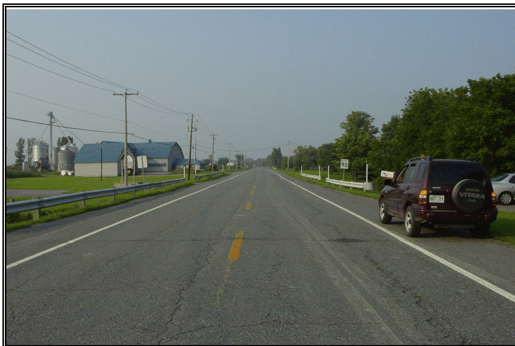
Photo 6 Projet 20-5371-0069, route 223, secteur 9, ponceaux J et K, km 11+507 et 11+536, vue vers le nord-est (NE)
