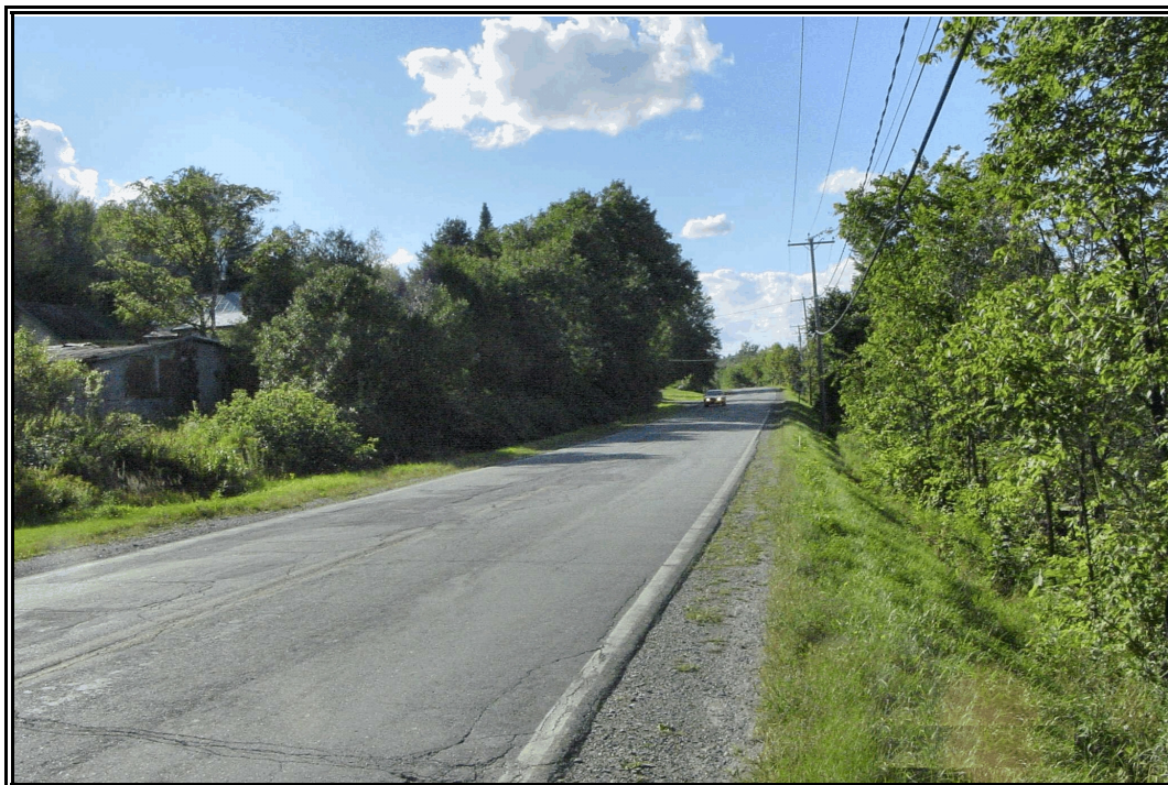
Photo 15 Projet 20-5373-9320, route 243, secteur 2, vue générale du ponceau 2, vers le nord-ouest (NO)
