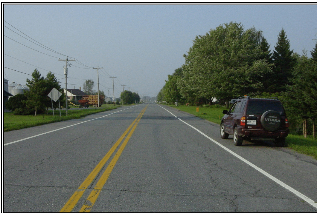
Photo 5 Projet 20-5371-0069, route 223, secteur 7, ponceau H, km 11+003, vue vers le nord-est (E)
