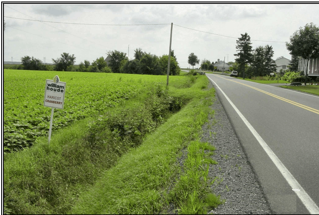
Photo 11 Projet 20-5372-9812, route 224, secteur 1, vue générale de l'extrémité nord-est côté sud-est, vers le sud-ouest (SO)
