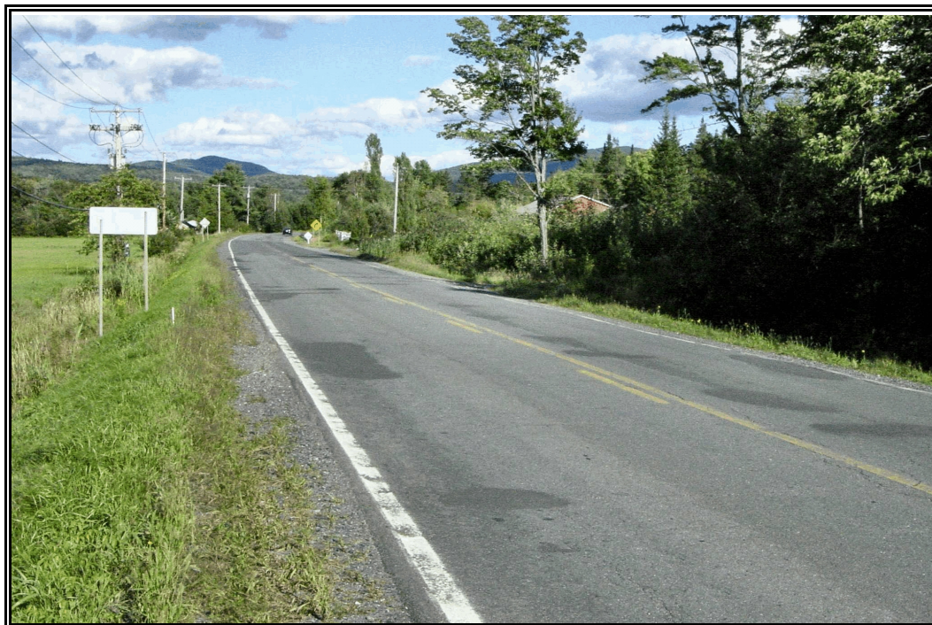
Photo 18 Projet 20-5373-9320, route 243, secteur 5, vue générale du ponceau 5, vers le sud-est (SE)
