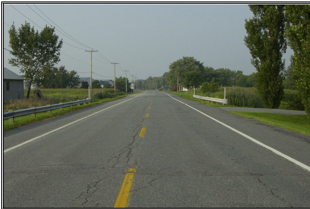
Photo 7 Projet 20-5371-0069, route 223, secteur 12, ponceau M, km 11+889, vue vers le nord-est (NE)
