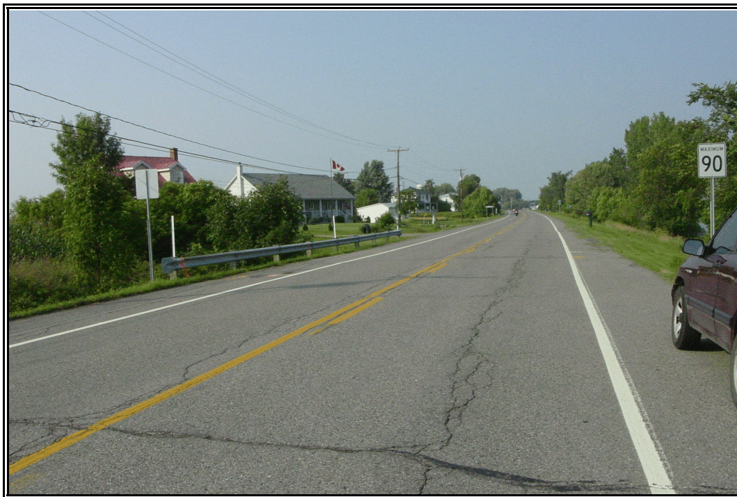
Photo 1 Projet 20-5371-0069, route 223, secteur 1, ponceau A, km 7+348, vue vers le nord-est (NE)
