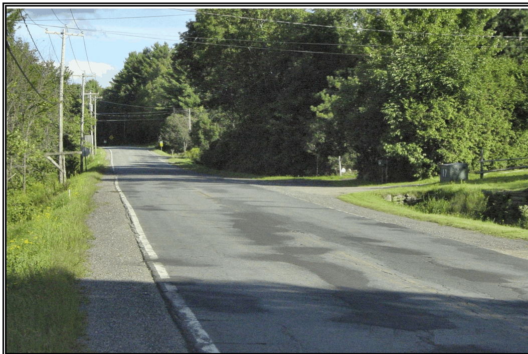
Photo 16 Projet 20-5373-9320, route 243, secteur 3, vue générale du ponceau 3, vers le sud-est (SE)
