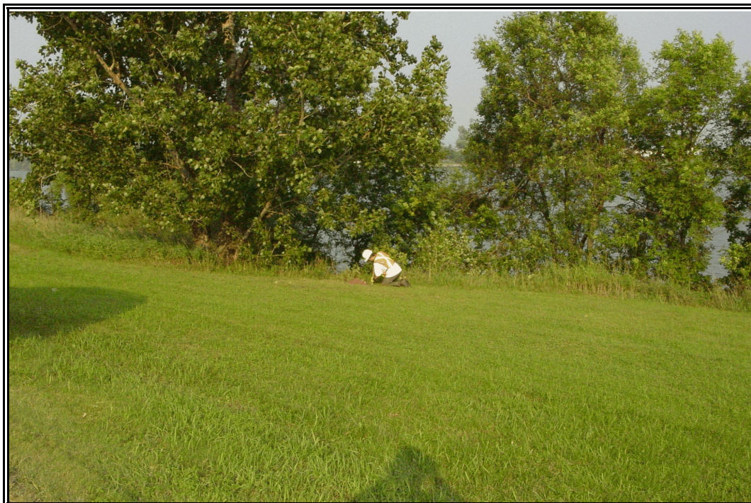
Photo 3 Projet 20-5371-0069, route 223, secteur 3, ponceau C, km 8+513, sondage en cours, vue vers l'est (E)
