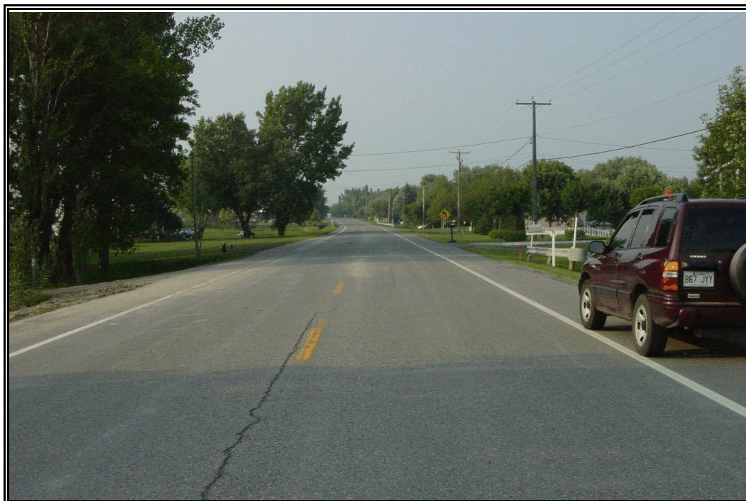
Photo 4 Projet 20-5371-0069, route 223, secteur 5, ponceau F, km 9+990, vue vers le nord-est (NE)
