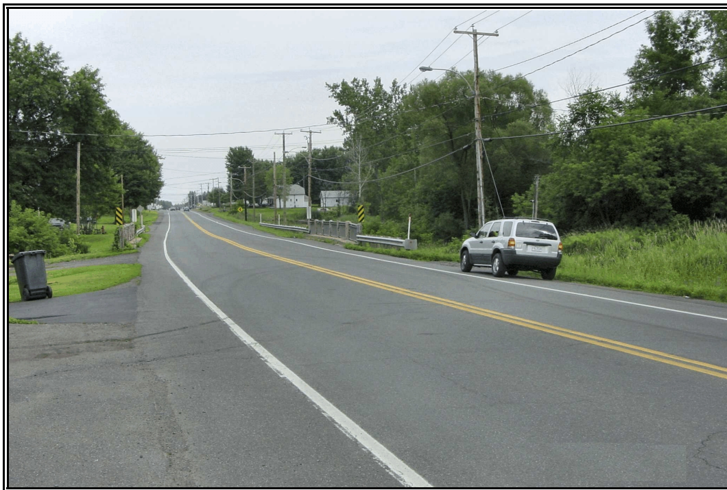
Photo 9 Projet 20-5372-9805, route 132, secteur 1, vue générale vers le sud-est (SE)
