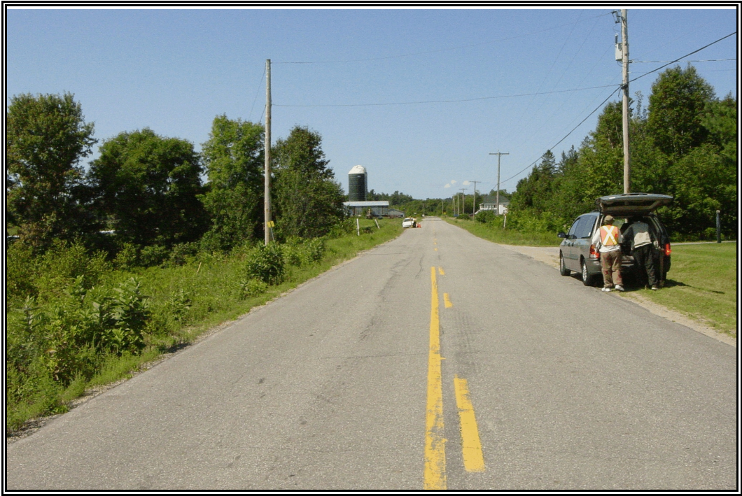
Photo 2 Projet 5674-0260, chemin Calumet, secteur 2, vue générale vers l'ouest (O)
