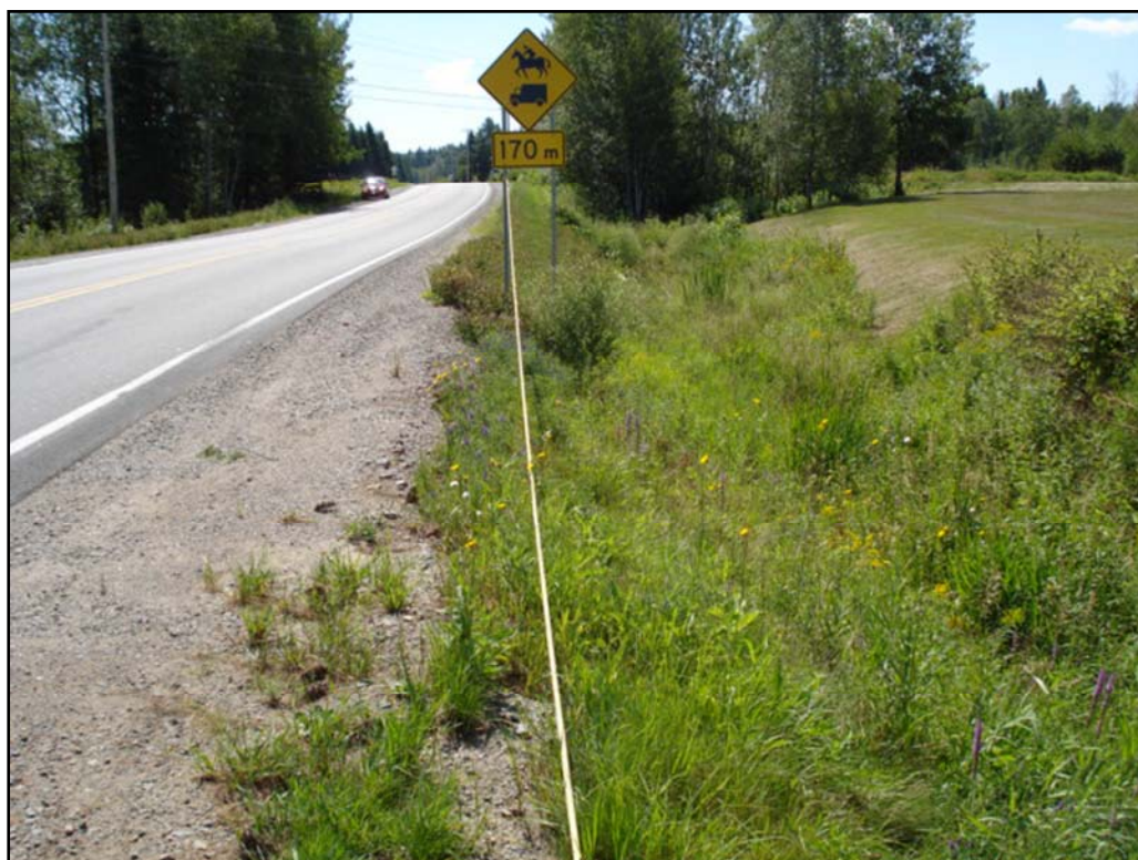
Photo 8 : Ponceau 1, partie sud du secteur 2, direction sud (154-07-1505-10-NUM1-4)
