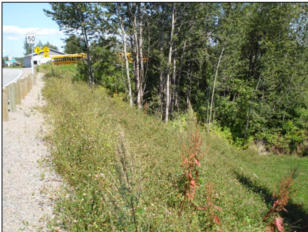
Photo 10 : Remblai, arbres et arbustes, extrémité est du ponceau 2, secteur 1, direction nord (154-07-1505-10-NUM1-10)
