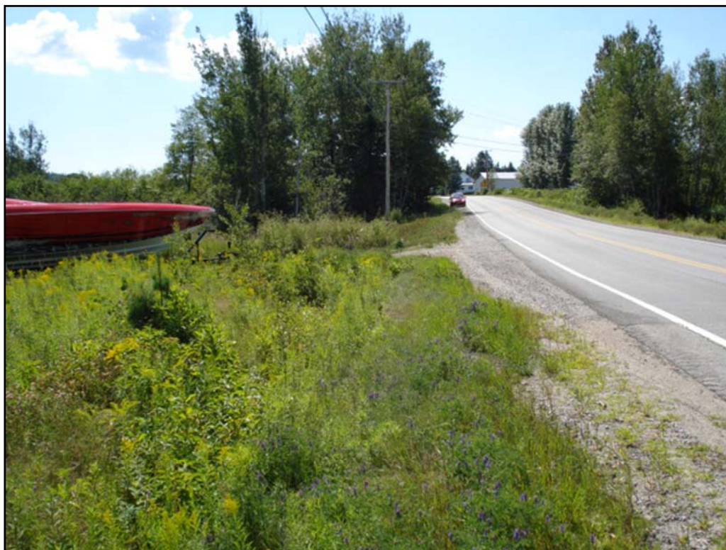
Photo 7 : Ponceau 1, secteur 1, côté est de la route 352, direction nord (154-07-1505-10-NUM1-3)
