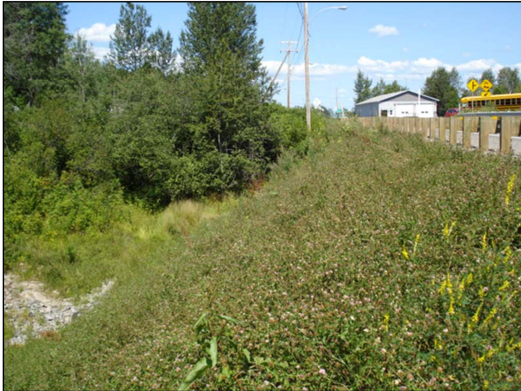
Photo 9 : Remblai à l'extrémité ouest du ponceau 2, secteur 2, direction nord (154-07-1505-10-NUM1-9)
