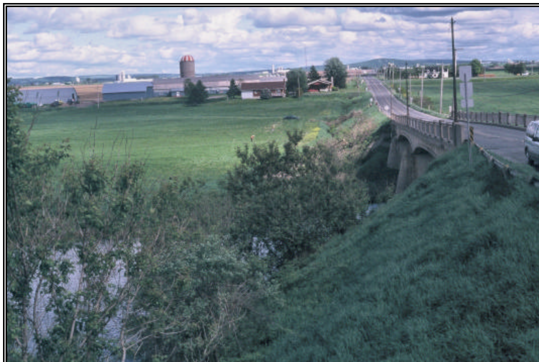
Photo 8 Projet 20-6474-9809, route de Warwick, secteurs 2 et 1, partie est de l'emprise, vue à partir du km 3+740, vers le sud-sud-est
