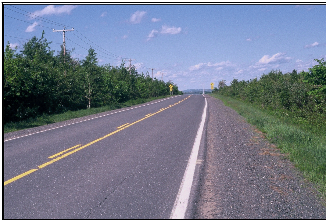
Photo 12 Projet 20-6475-9518-B, route 255, secteur 7, vue générale à partir du km 3+045, vers le nord-est
