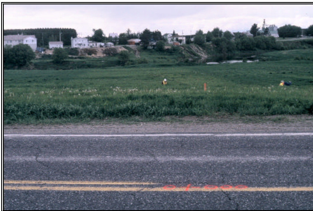
Photo 5 Projet 20-6474-8659-A, route Saint-Albert-de-Warwick, secteurs 1 et 2, vue d'ensemble à partir du km 0+000, vers le nord
