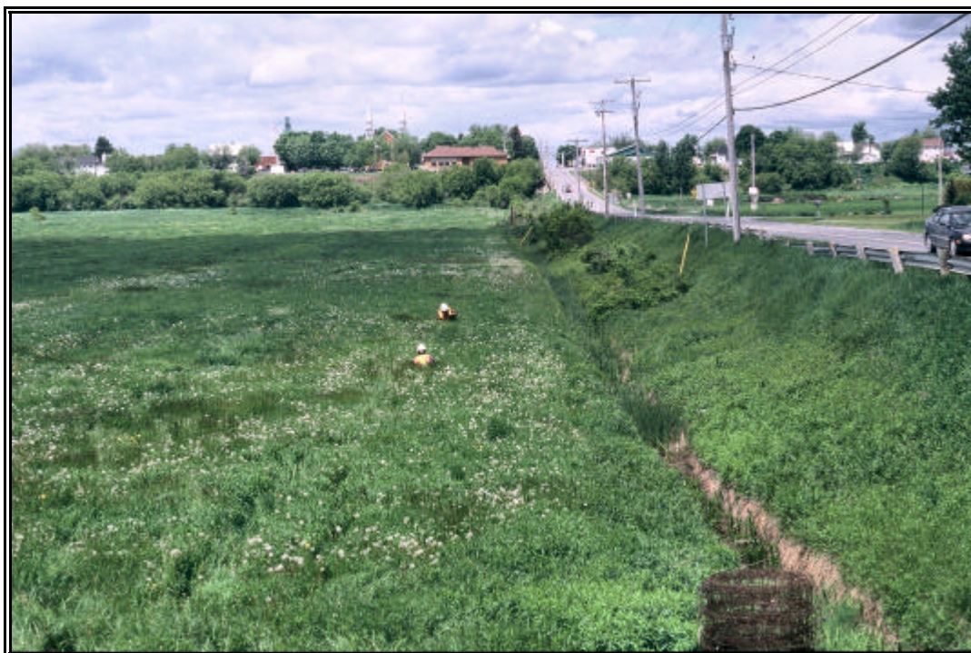
Photo 7 Projet 20-6474-9809, route de Warwick, secteur 1, partie ouest de l'emprise, vue à partir du km 3+200, vers le nord-nord-ouest
