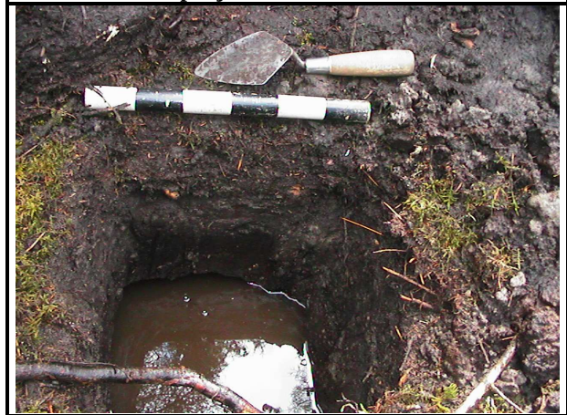
Photo 6 : sondage dans une zone mal drainée – projet 20-3671-8927.
