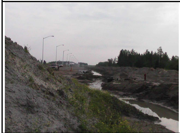
Photo 6 : début de la zone, vue de la tranchée.
