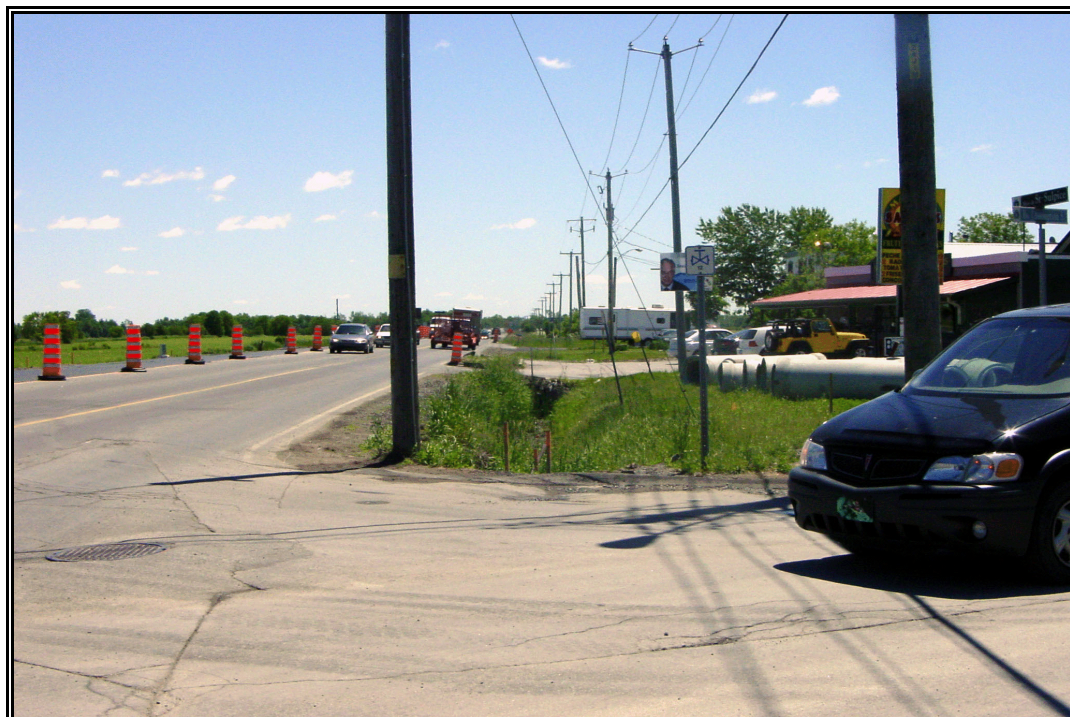
Photo 2 Projet 20-5172-8814, route 343, secteur 1, vue générale à partir du km 1+600, vers le sud-sud-est (SSE)
