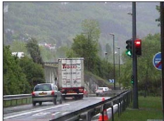
*Fin de la bretelle de sortie avec feux tricolores pour les VP et feu R17 pour le TC*
