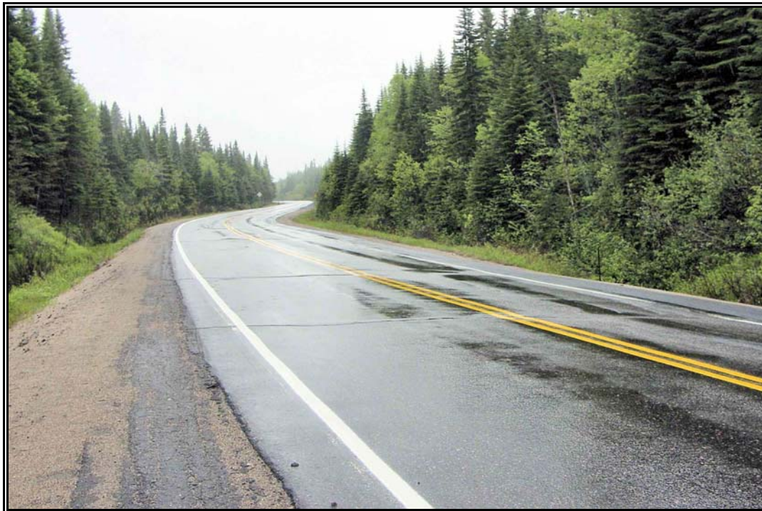
Photo 3 Projet 20-3572-0355, route 138, Port-Cartier, secteur 1, vue générale, ponceau zone 138-93-430 au km 0+764, vers le nord (PATR05N5-8)
