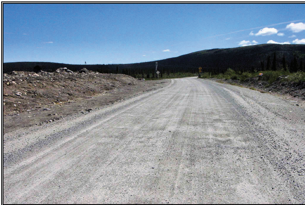
Photo 21 Projet 20-3573-0442, route 389, Gueslis, secteur 1, vue générale du centre ligne, tronçon 389-04-170, au km 5+990, vers l'est (PATR05N5-20)
