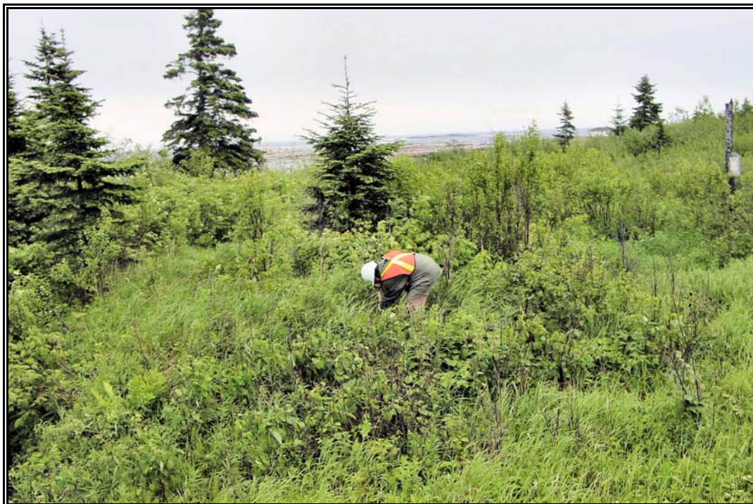
Photo 4 Projet 20-3572-0355, route 138, Baie-Trinité, secteur 5, vue du côté nord-est de l'emprise avec équipe au travail, ponceau zone 138-93-371 au km 5+302, vers l'est (PATR05N5-10)
