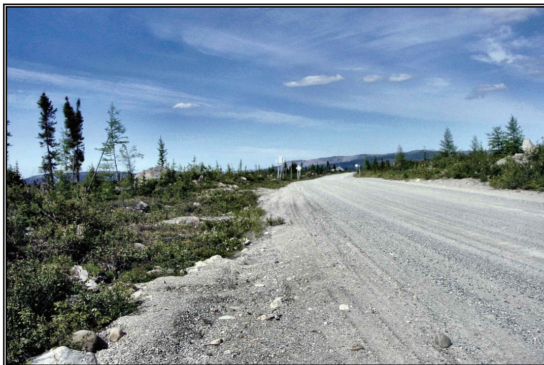
Photo 26 Projet 20-3573-0442, route 389, Gueslis, secteur 4, vue générale, tronçon 389-04-160, au km 4+215, vers le nord-nord-est (PATR05N5-38)
