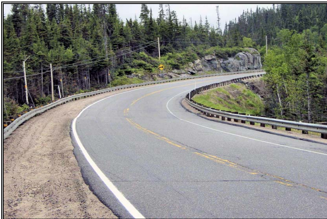
Photo 5 Projet 20-3572-0355, route 138, Godbout, secteur 4, vue générale, ponceau zone 138-93-371 au km 1+328, vers le nord-ouest (PATR05N5-13)
