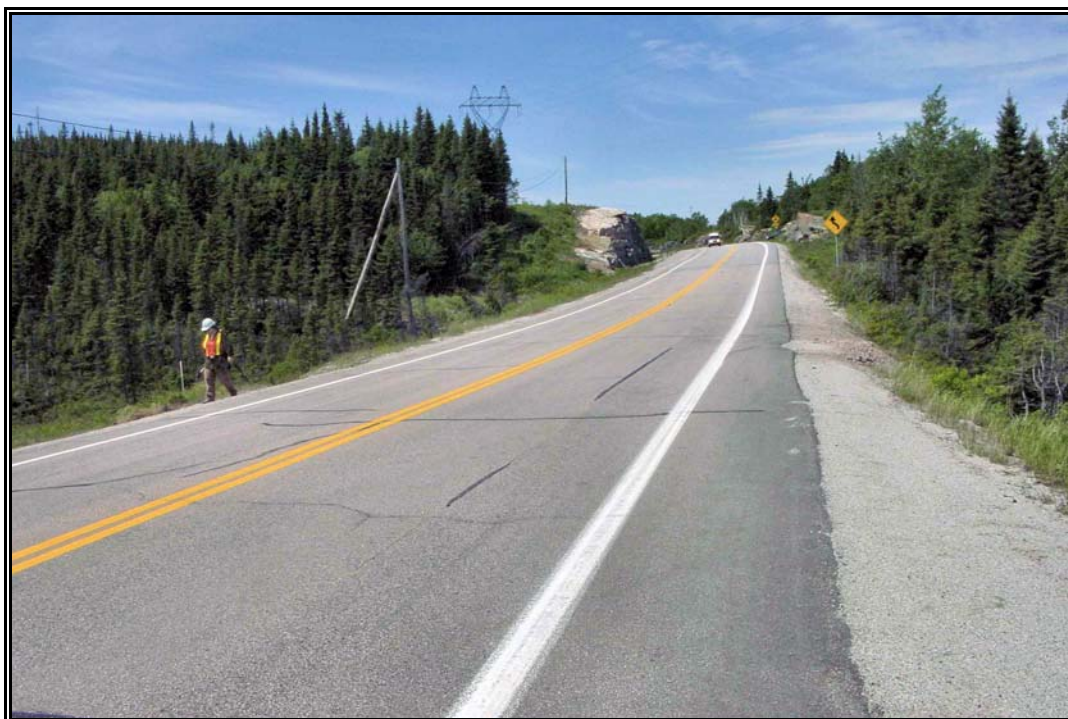
Photo 11 Projet 20-3573-0359, route 138, Baie-Comeau, secteurs 3 et 4, vue générale, ponceaux zone 138-93-310 aux km 11+312 et 11+350, vers l'ouest (PATR05N6-47)
