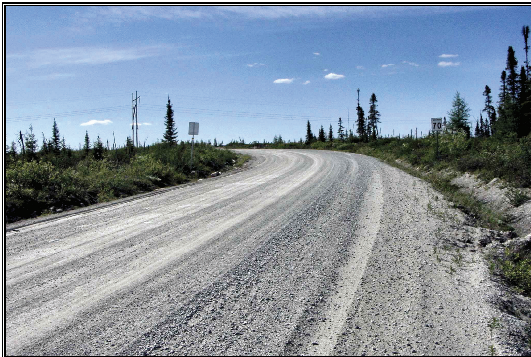
Photo 27 Projet 20-3573-0442, route 389, Gueslis, secteur 5, vue générale, tronçon 389-04-160, au km 4+815, vers le nord (PATR05N5-40)
