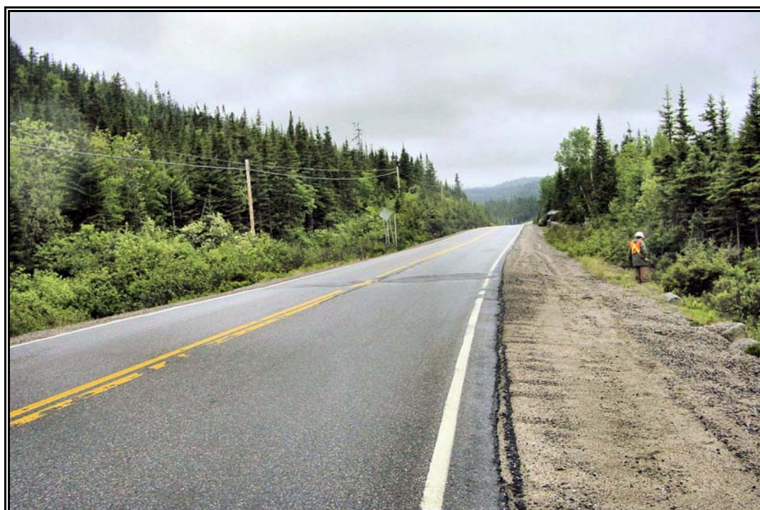
Photo 6 Projet 20-3572-0355, route 138, Godbout, secteur 3, vue générale, ponceau zone 138-93-371 au km 0+461, vers le nord-ouest (PATR05N5-14)
