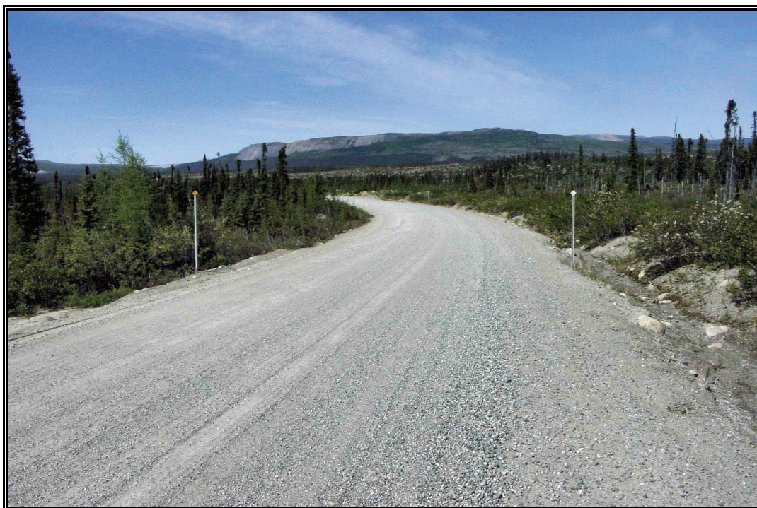
Photo 28 Projet 20-3573-0442, route 389, Gueslis, secteur 6, vue générale, tronçon 389-04-160, au km 6+170, vers le nord (PATR05N5-42)
