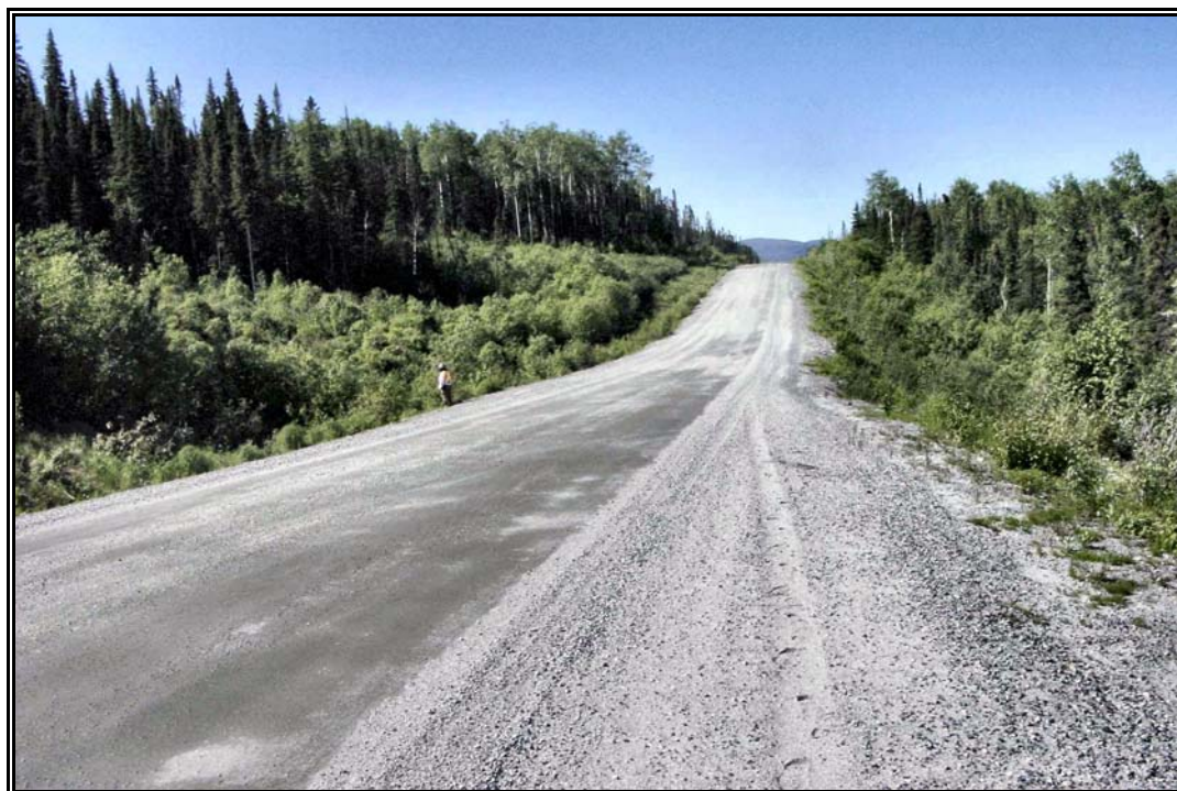
Photo 8 Projet 20-3573-0359, route 389, Rivière-aux-Outardes NO, secteur 6, vue générale, ponceau zone 389-03-020 au km 3+410, vers le sud-ouest (PATR05N6-11)
