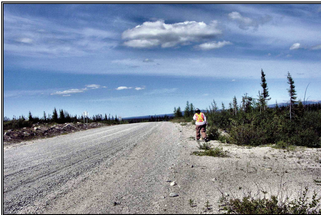
Photo 25 Projet 20-3573-0442, route 389, Gueslis, secteur 3, vue générale du côté est, tronçon 389-04-150, au km 3+610, vers le nord (PATR05N5-36)
