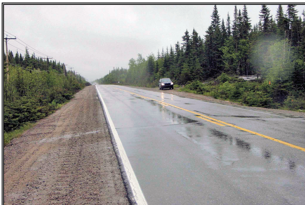
Photo 2 Projet 20-3572-0355, route 138, Port-Cartier, secteur 2, vue générale, ponceau zone 138-93-430 au km 7+297, vers l'est (PATR05N5-5)
