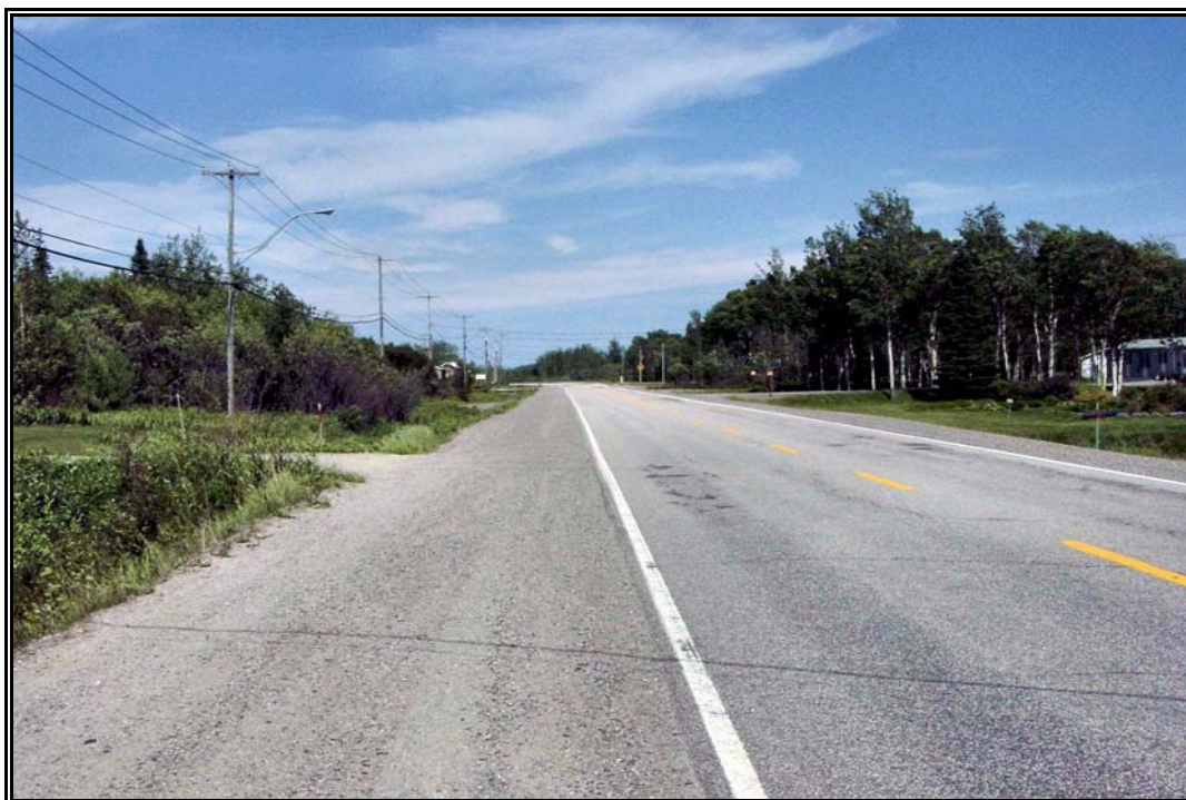
Photo 12 Projet 20-3573-0359, route 138, Ragueneau, secteur 1, vue générale, ponceau zone 138-92-251 au km 11+399, vers l'est (PATR05N6-55)
