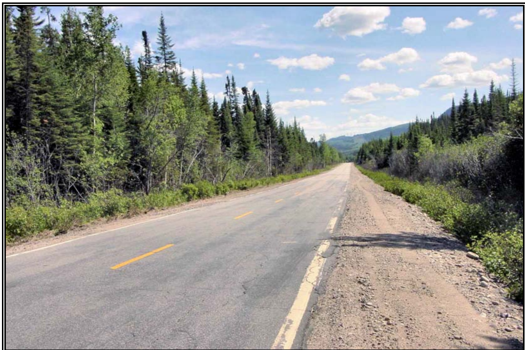
Photo 20 Projet 20-3573-9909, route 389, TNS, René-Lévesque, secteur 1, vue générale, au km 3+860, vers le sud-est (PATR05N6-30)
