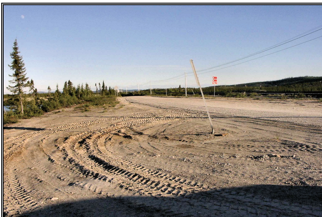
Photo 32 Projet 20-3573-0442, route 389, Gueslis, secteur 10, vue générale, tronçon 389-04-120, au km 2+345, vers le sud (PATR05N6-6)
