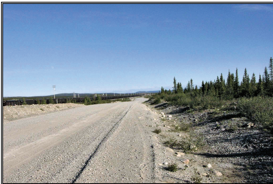
Photo 29 Projet 20-3573-0442, route 389, Gueslis, secteur 7, vue générale, tronçon 389-04-120, au km 4+580, vers le sud (PATR05N5-44)
