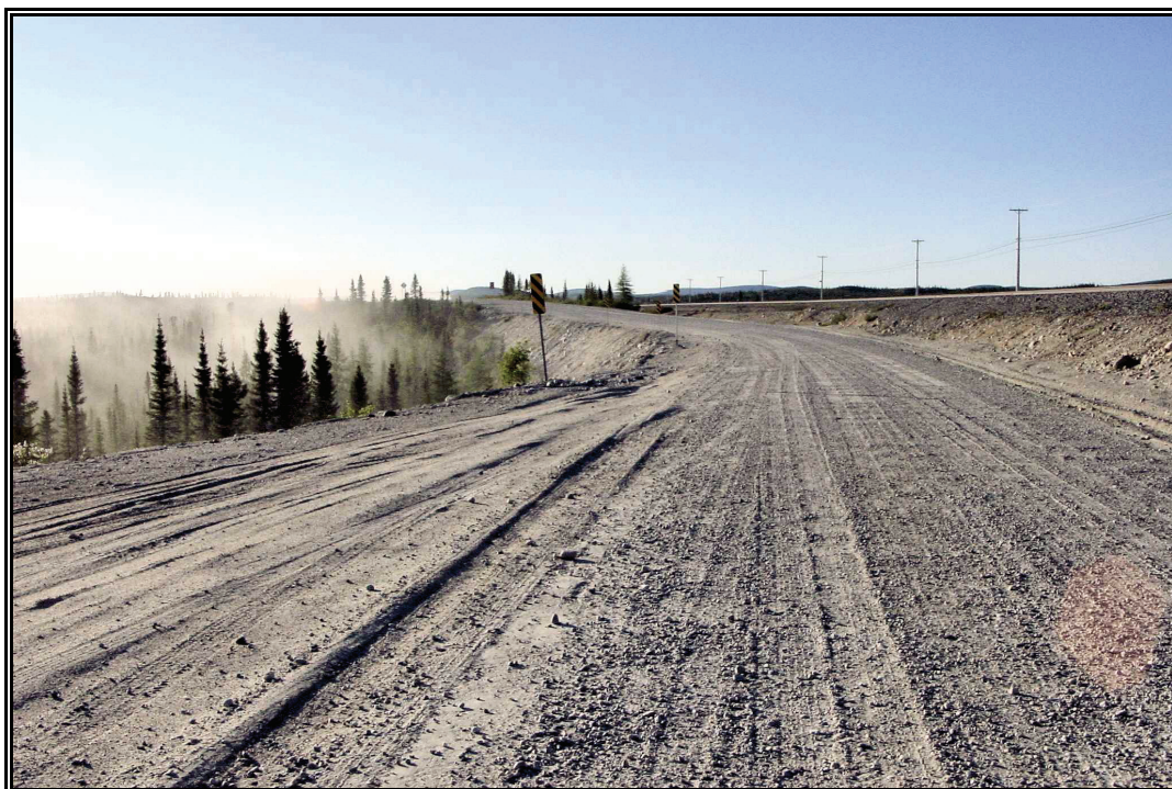
Photo 31 Projet 20-3573-0442, route 389, Gueslis, secteur 8, vue générale, tronçon 389-04-120, au km 2+625, vers le nord (PATR05N6-4)
