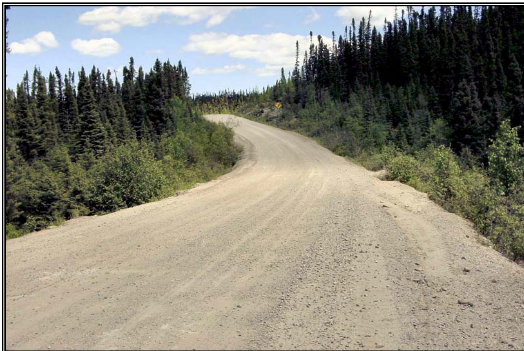
Photo 10 Projet 20-3573-0359, route 389, Rivière-aux-Outardes NO, secteur 9, vue générale, ponceau zone 389-02-180 au km 1+113, vers le nord (PATR05N6-18)
