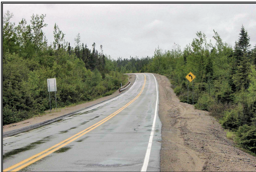
Photo 1 Projet 20-3572-0355, route 138, Moisie, secteur 7, vue générale, ponceau zone 138-10-020 au km 9+915, vers l'ouest (PATR05N5-1)
