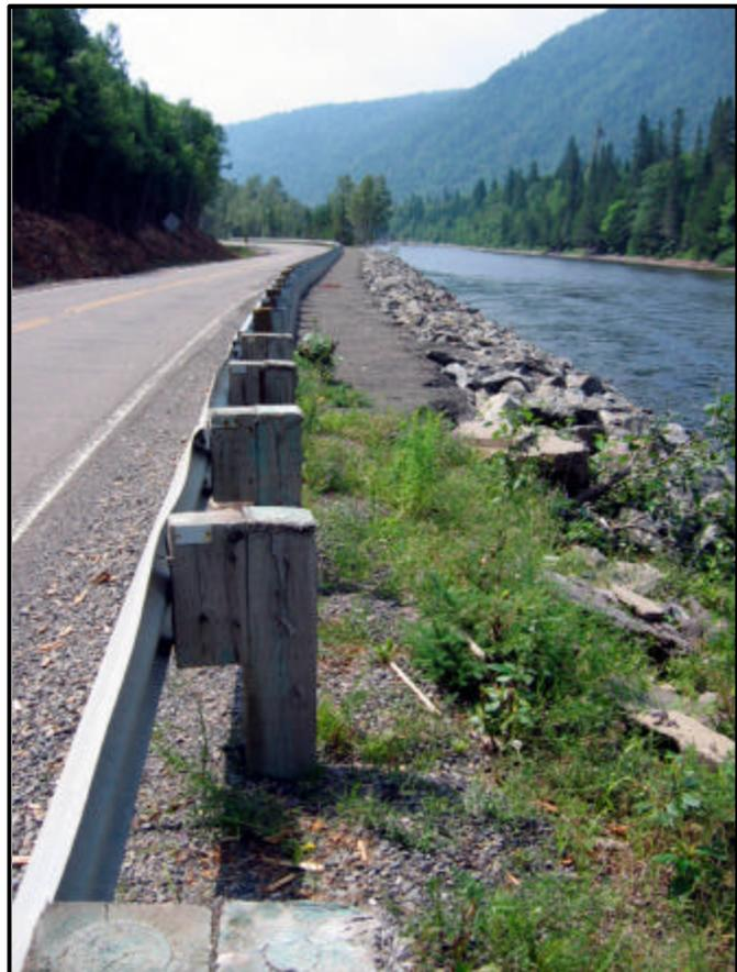
Photo 2 : Empierrement et asphaltage à l'emplacement n° 3, aux environs du km 27,35 de la route 299, en direction sud (20-3174-04B8-NUM1-8)
