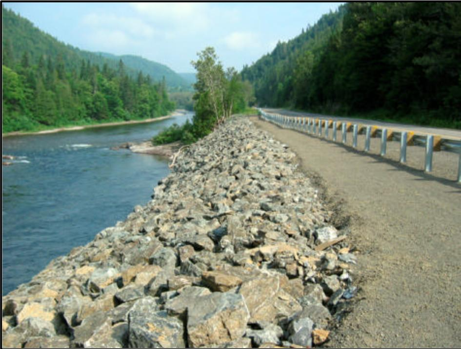
Photo 1 : Empierrement bordant l'emplacement n° 1, aux environs du km 16,8 de la route 299, en direction nord (20-3174-04B8-NUM1-1)
