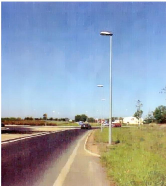
*Mâts à absorption d'énergie installés sur le giratoire de Lunel-Viel (34)*
