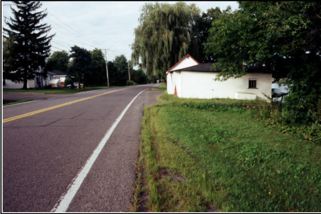
Photo 24 : Bâtiment construit dans les limites de l'emprise du ministère des Transports (20-5474-0423-D1-5)
