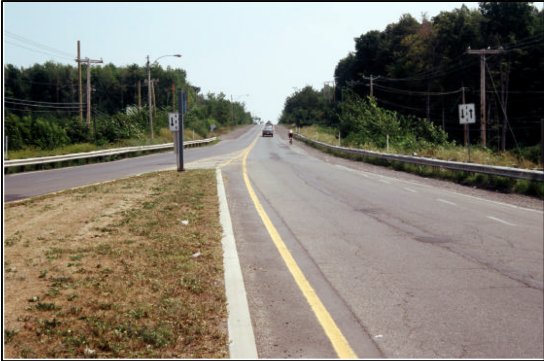
Photo 5 : Vue générale du secteur 1 dans la portion ouest de l'aire des travaux (20-5473-9508-D1-1)
