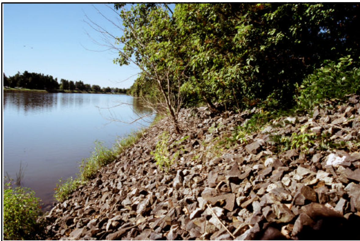
Photo 23 : Consolidation de la berge dans le secteur 2 (20-5474-0423-D2-4)
