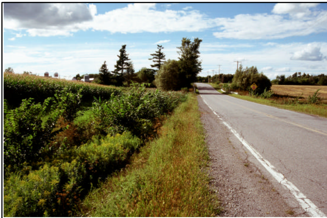
Photo 10 : Vue générale du secteur 3 dans la portion sud-ouest du projet (20-5472-9919-D1-5)
