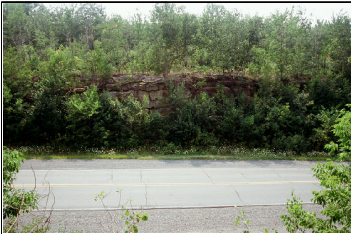
Photo 6 : Vue en coupe d'une section de la paroi rocheuse dans le secteur 2 (20-5473-9508-D1-10)
