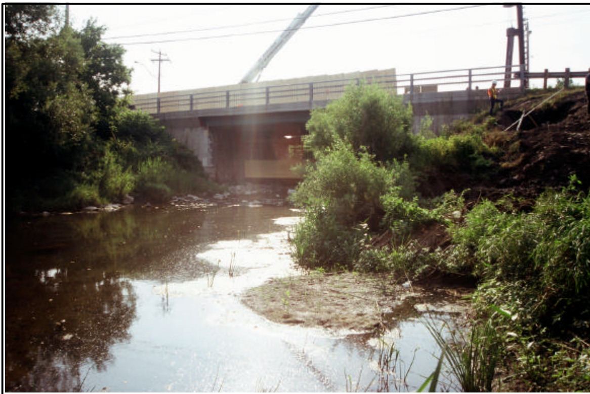
Photo 2 : Pont n° 1746 et rivière à l'Esturgeon, vue de la rive ouest (20-5472-9901-D1-9)
