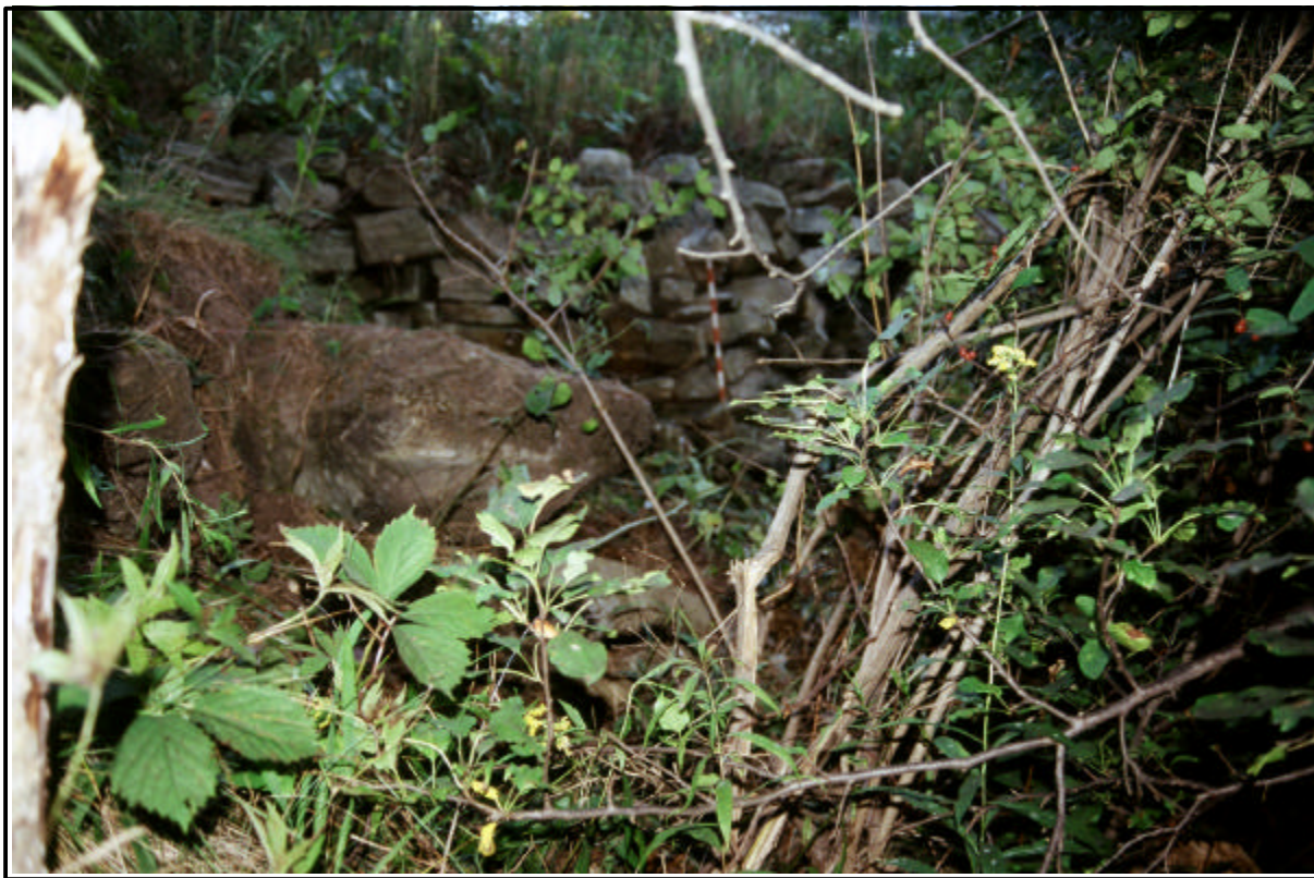
Photo 17 : Sommet de l'ancienne culée du pont (20-5471-9828-D1-5)
