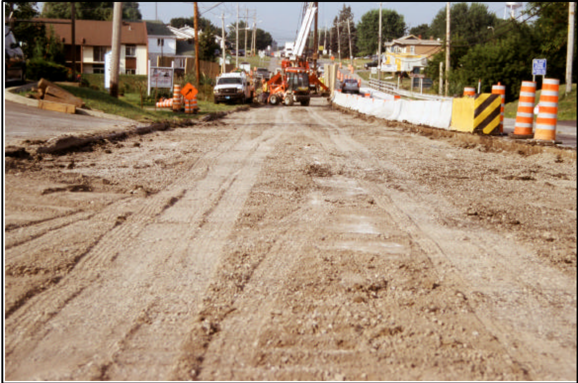
Photo 1 : Vue générale de l'aire des travaux de l'entrepreneur en construction mandaté par le MTQ, depuis l'extrémité nord de l'emprise (20-5472-9901-D1-2)
