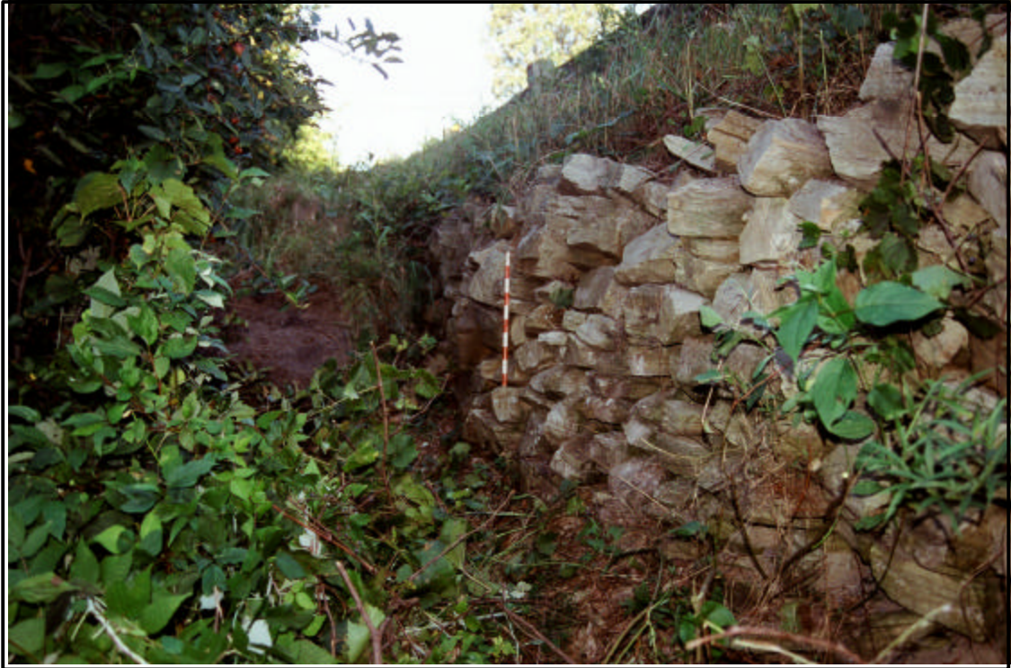
Photo 15 : Mur de soutènement de la route en pierres sèches à proximité du ponceau (20-5471-9828-D1-4)
