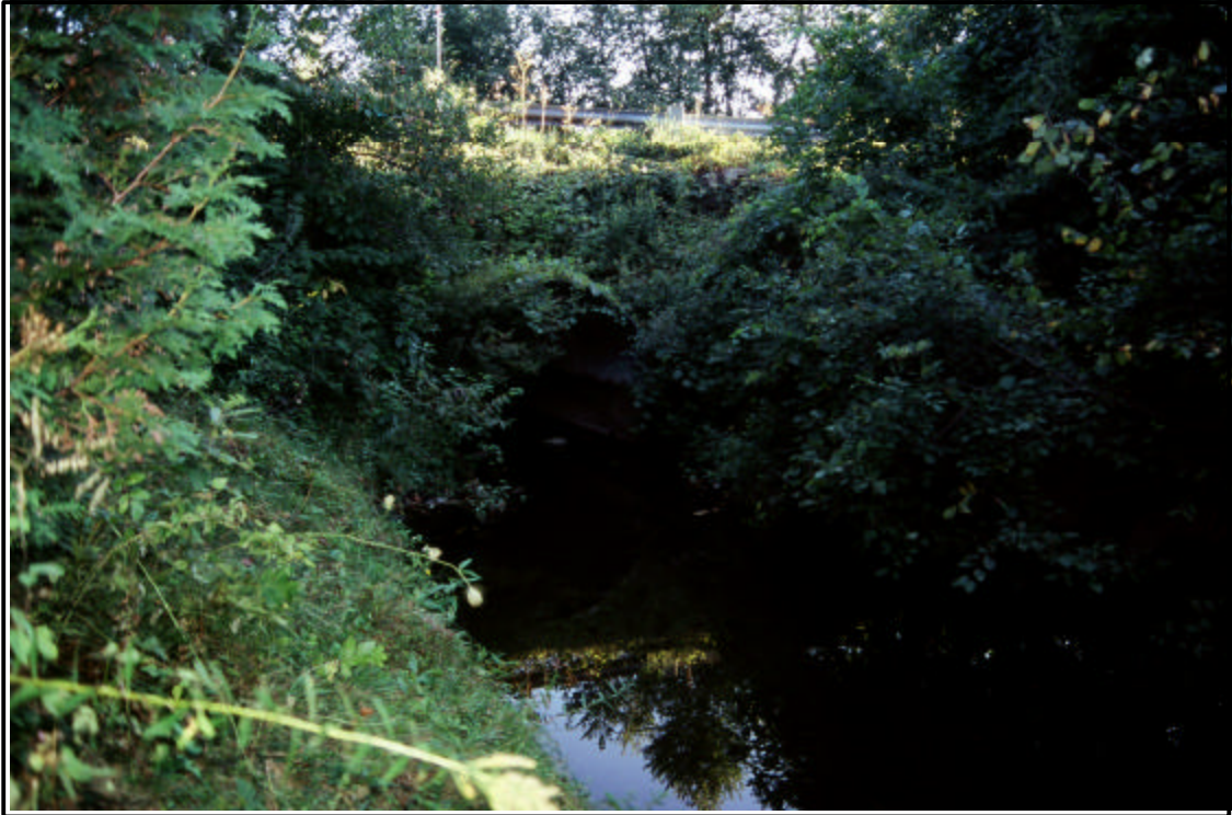
Photo 13 : Vue générale de la rivière et du ponceau du côté nord (20-5471-9828-D1-3)
