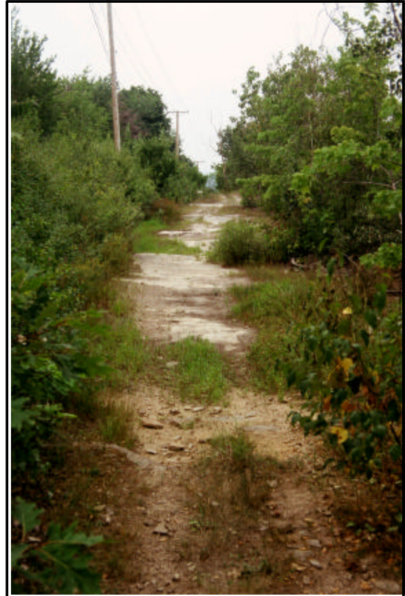
Photo 8 : Vue générale de l'affleurement rocheux dans le secteur 2 (20-5473-9508-D1-15)
