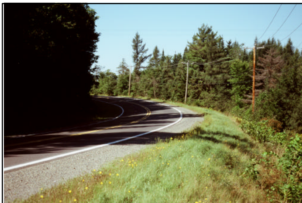
Photo 24 : Vue générale de la courbe du site 3 où la route 243 est aménagée sur un replat en pente légère (20-5373-9835-D1-8).
