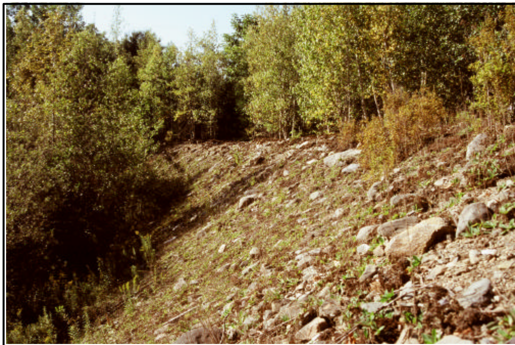
Photo 23 : Épais talus de matériaux d'origine glaciaire, utilisés comme matériaux de construction pour la route 243 à proximité du site 4 (20-5373-9835-D1-16).
