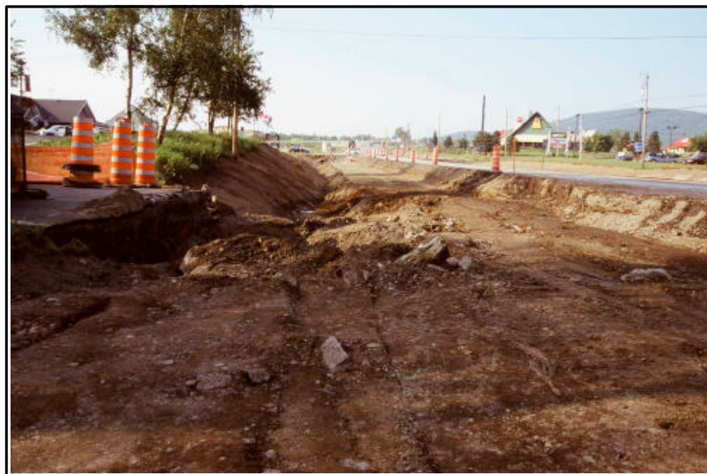
Photo 9 : État d'avancement des travaux sur le boulevard Bromont (20-5373-0443-D1-5).
