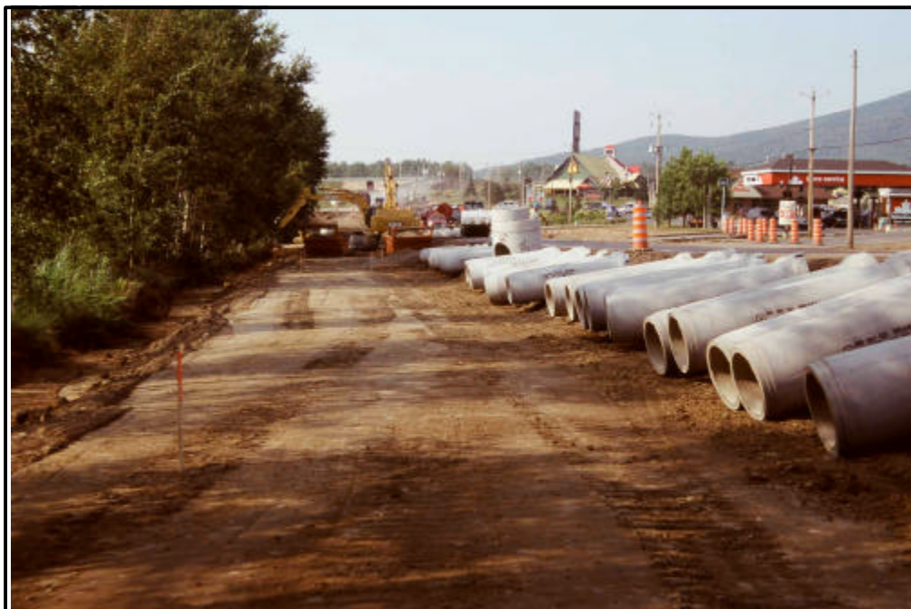
Photo 8 : Vue générale de l'état d'avancement des travaux et des commerces environnants (20-5373-0443-D1-2).
