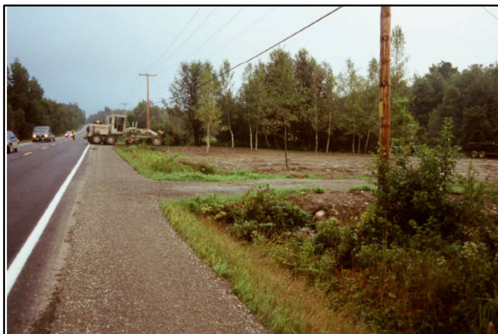
Photo 28 : Développement d'un quartier résidentiel du côté ouest de la route 241 (20-5373-9835-D2-7)
