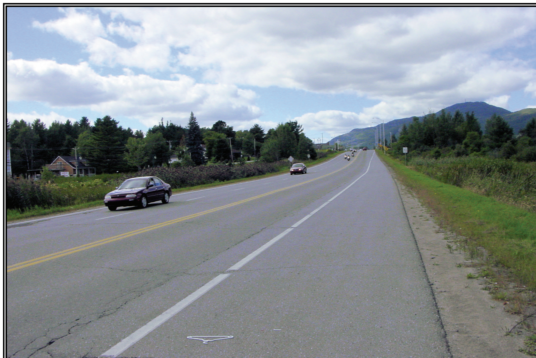
Photo 8 Projet 20-5700-0425, route 112 et chemin Southière, Magog, secteur 1, vue générale à partir du km 1+240 vers le nord-ouest (PATR05N1-80)
