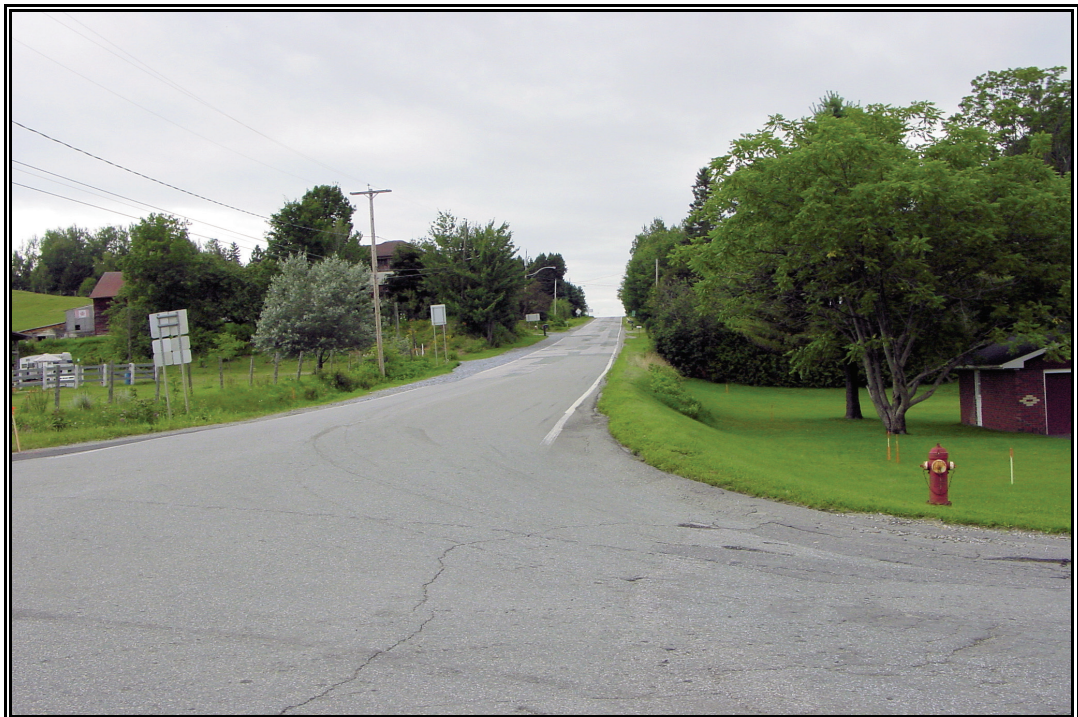
Photo 4 Projet 20-5700-0165, routes 214 et 255, Bury, secteur 1, vue générale à partir du km 1+000 vers l'ouest (PATR05N1-64)
