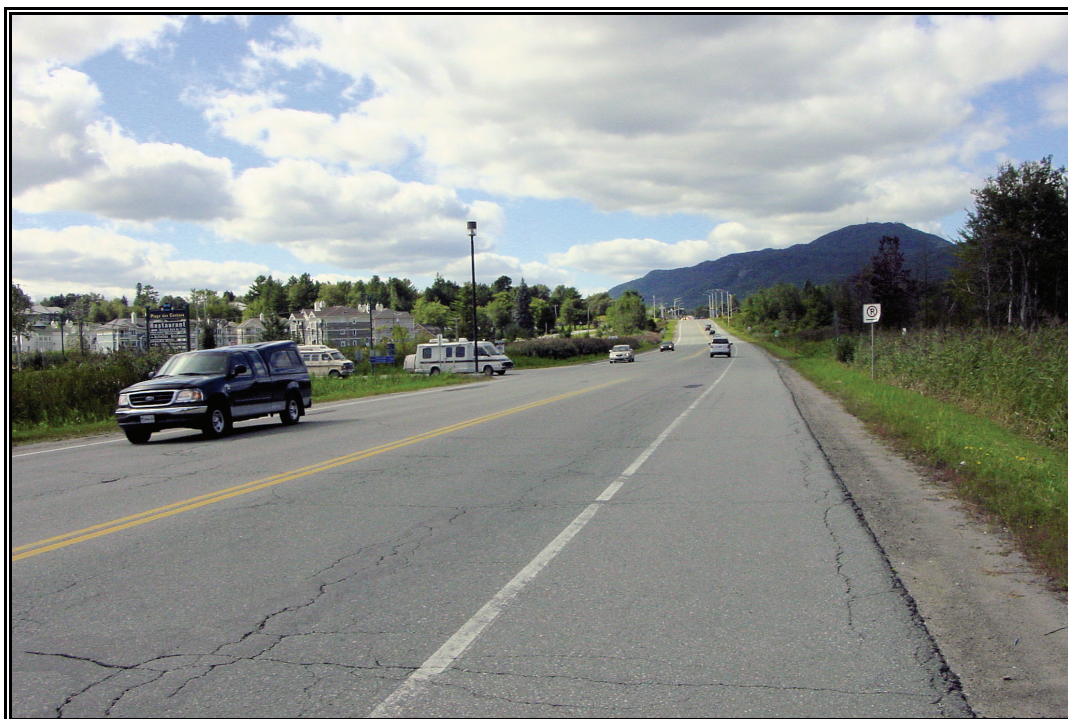
Photo 7 Projet 20-5700-0425, route 112 et chemin Southière, Magog, secteur 1, vue générale à partir du km 1+430 vers le nord-ouest (PATR05N1-79)
