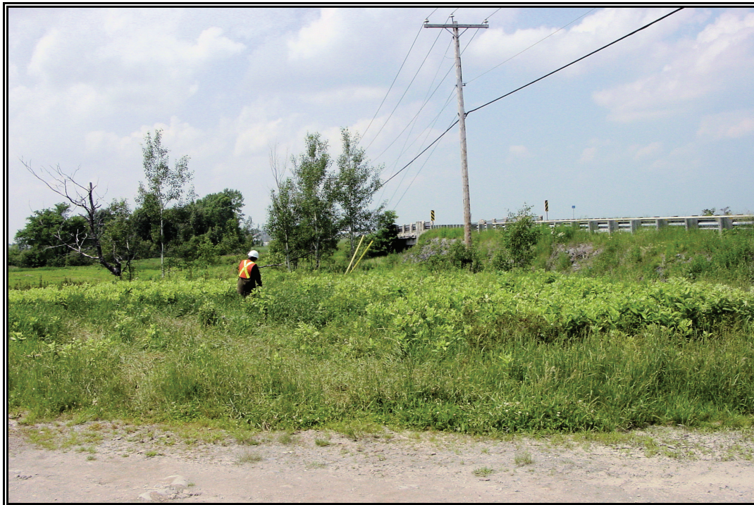
Photo 1 Projet 20-6174-9309, route 216, Wotton, secteur 2, vue générale à partir du km 0+570, vers le nord (PATR05N1-17).
