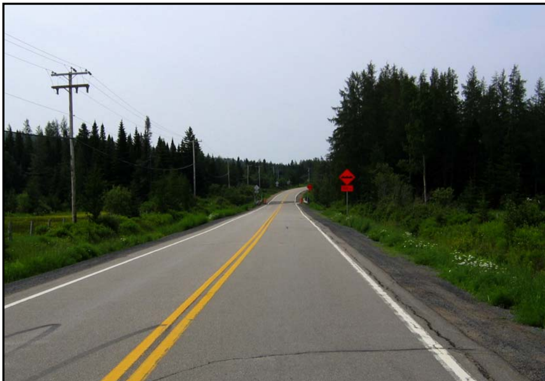
Photo 2 : Chemin des Loisirs et pont à reconstruire (P-1696), direction sud (20-3971-3515-06-NUM1-1)
