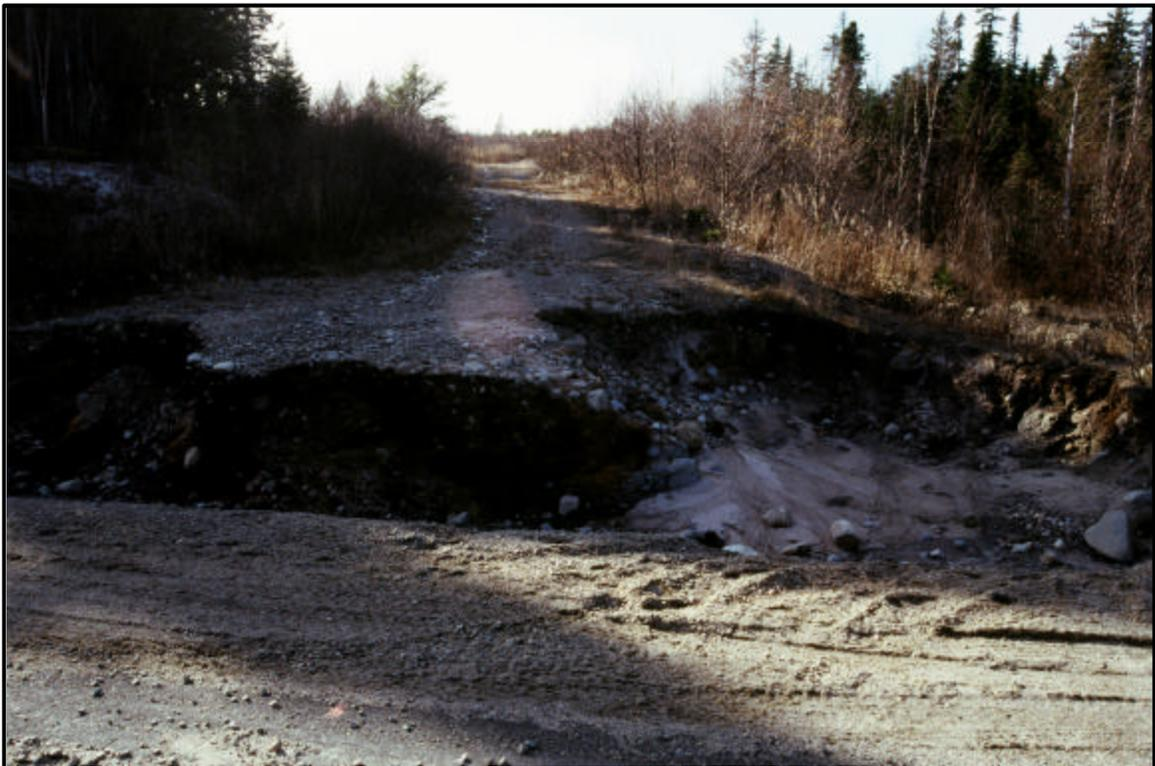
Photo 62 : Érosion, côté nord de la route 138, municipalité de Baie-Trinité, en direction nord (20-3572-0555-D2-15)
