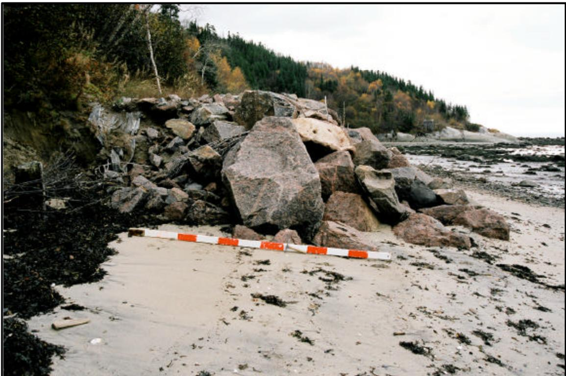
Photo 49 : Talus stabilisé, empierrement, municipalité de Franquelin, en direction est (20-3573-0556-C9-9)
