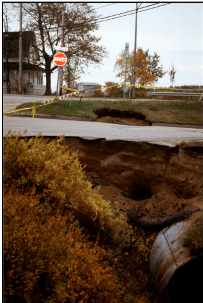
Photo 4 : Effondrement d'une partie de la chaussée, ponceau sur la route du Vallon, en direction sud, projet de réfection du ponceau du ruisseau du Pied-des-Crans (20-3574-0554-D1-5)
