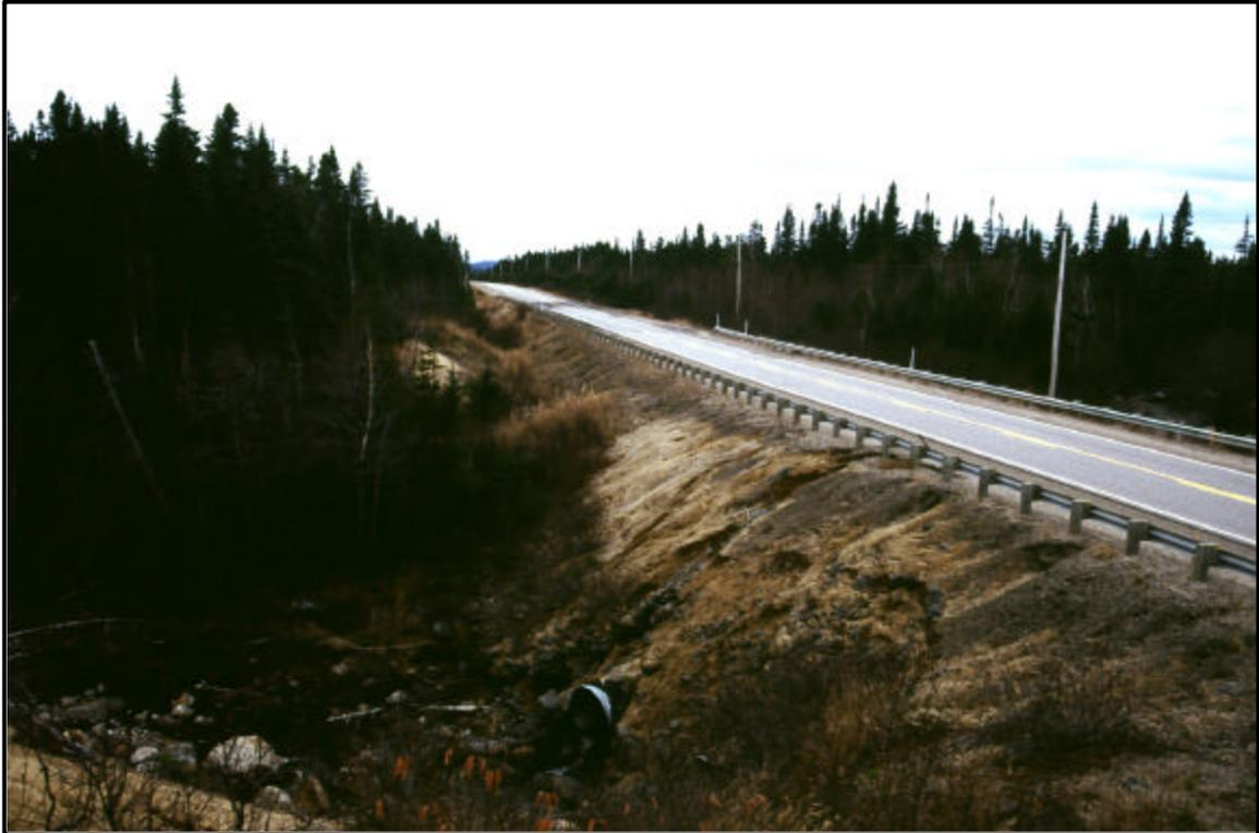
Photo 65 : Érosion, ponceaux, 3 km à l'ouest de Pointe-aux-Anglais, en direction ouest (20-3572-0555-D4-22)
