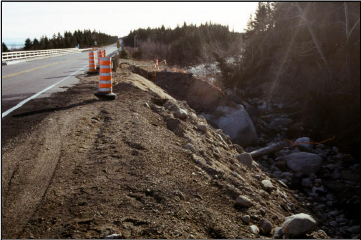
Photo 61 : Érosion, pont du ruisseau long, municipalité de Baie-Trinité, en direction ouest (20-3572-0555-D2-18)
