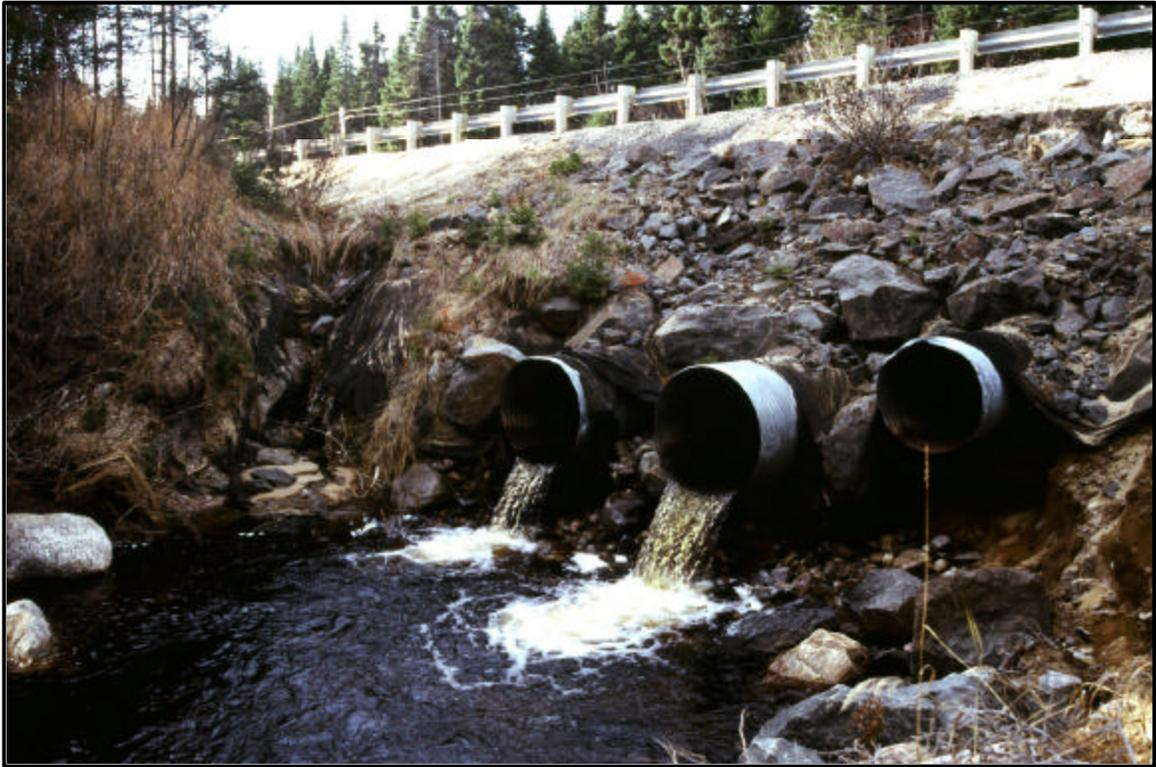
Photo 63 : Érosion, ponceaux, ruisseau à l'Ours et une partie des dommages causés, route 138, municipalité de Baie-Trinité, en direction nord (20-3572-0555-D3-15)
