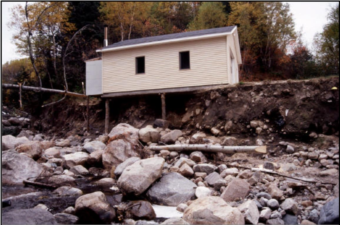
Photo 11 : Érosion, rive gauche du ruisseau Rouge, en direction est (20-3574-0553-D1-12)
