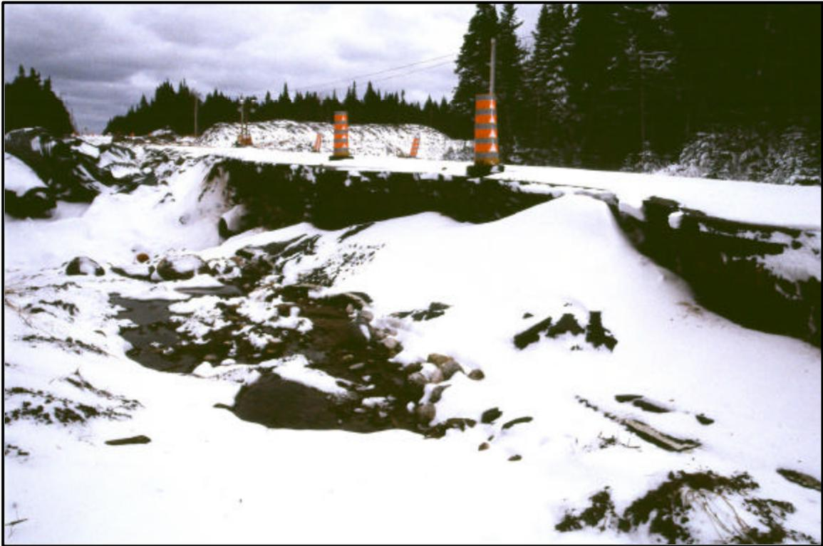
Photo 58 : Érosion, tronçon de la route 138, municipalité Les Islets-Caribou, en direction ouest (20-3572-0548-D1-4)
