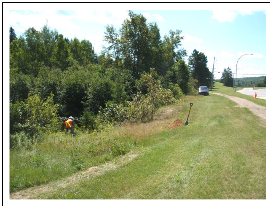
Photo 1 : (N.1-013) boul. Fernand-Lafontaine, Rivière-Rouge, km 1+085, vu vers le sud, côté nord-est du pont
