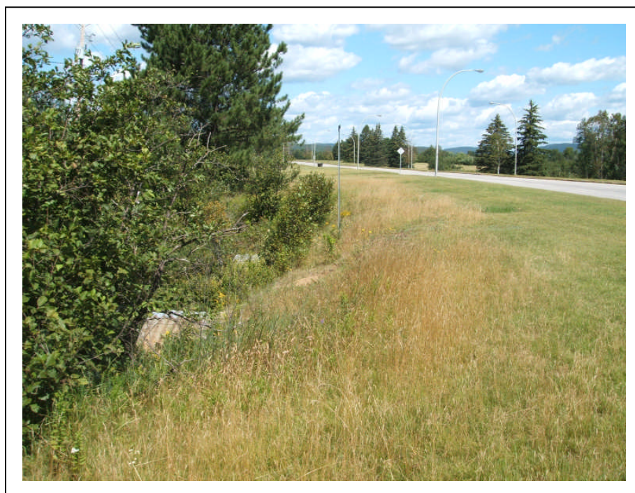
Photo 2 : (N.1-015) boul. Fernand-Lafontaine, Rivière-Rouge, km 1+130, vu vers le nord, côté ouest du pont
