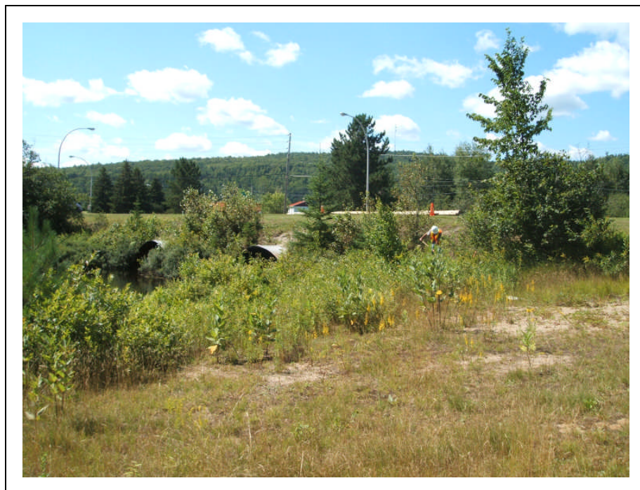
Photo 4 : (N.1-020) boul. Fernand-Lafontaine, Rivière-Rouge, km 1+085, vu vers l'ouest, côté nord-est du pont
