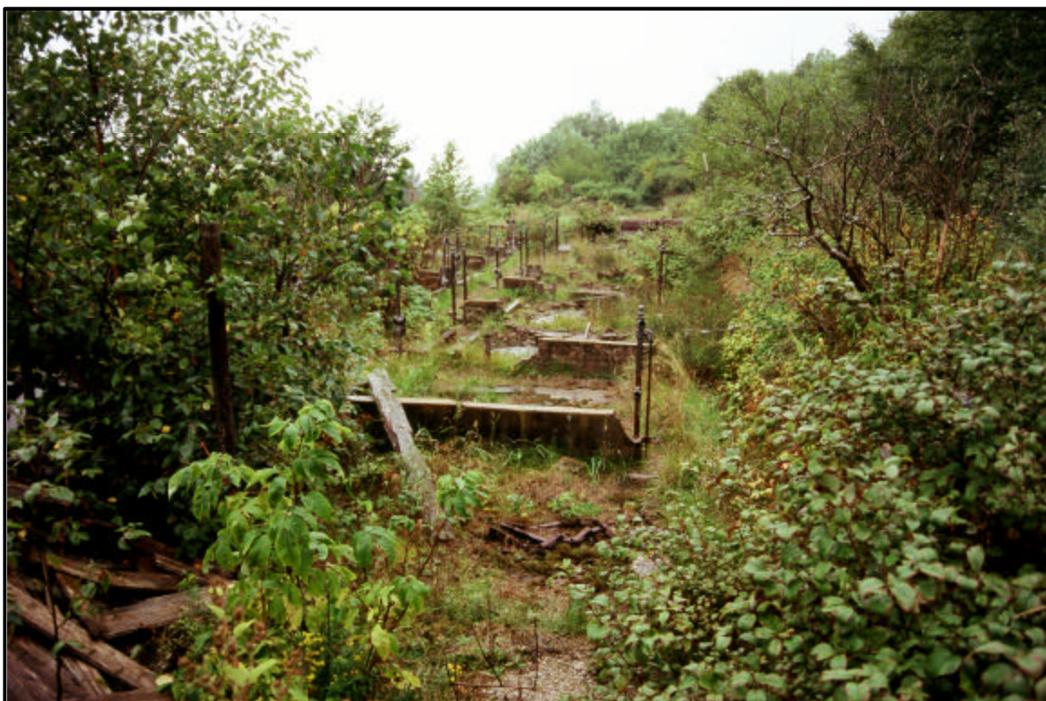
Photo 10 : Vue générale des murs de fondation en béton du poulailler et de la porcherie de la ferme Saint-Joseph dans le secteur 7 de la zone 2 (20-3174-8406-D2-16)
