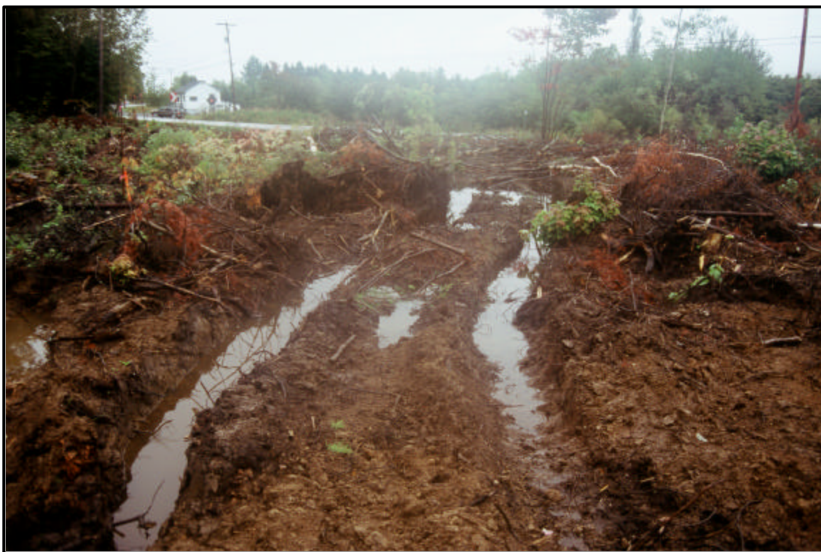
Photo 8 : Traces laissées par le passage d'une débroussailleuse et de véhicules lourds dans le secteur 5 de la zone 2 (20-3174-8406-D6-9)
