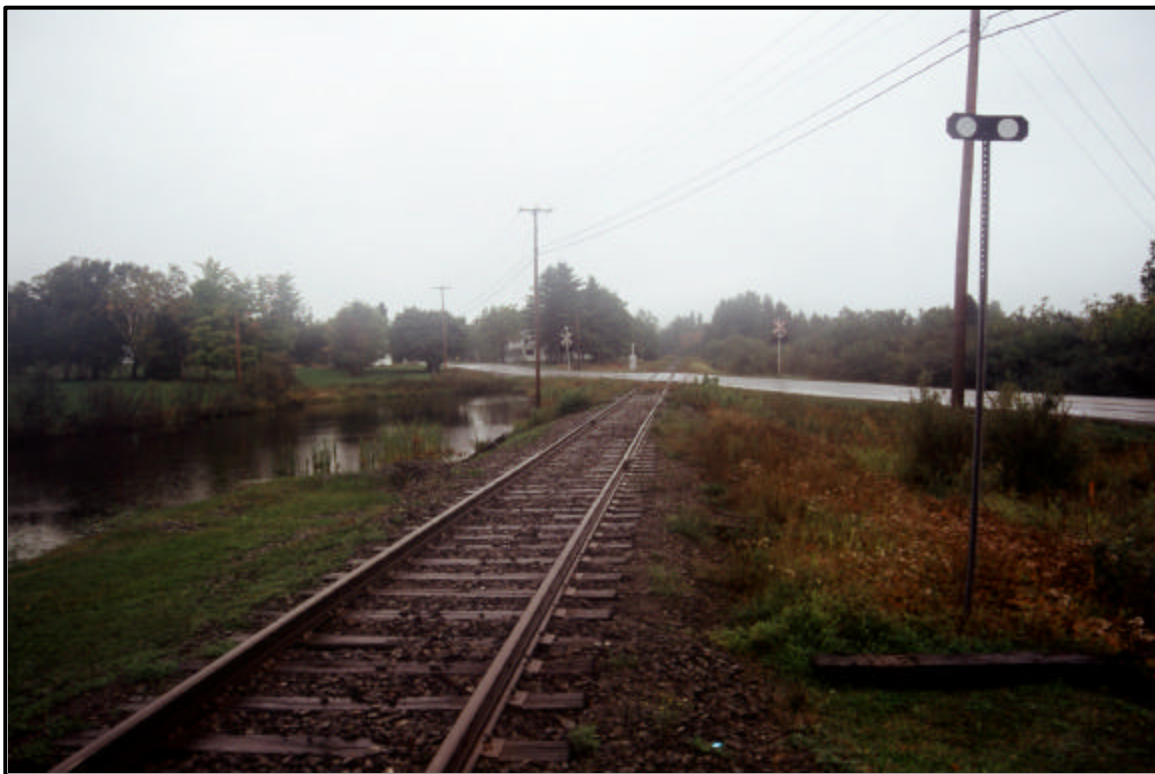
Photo 7 : Vue générale de l'intersection entre le chemin de fer et la route 132 qui délimite la zone 2 à l'ouest (20-3174-8406-D6-3)
