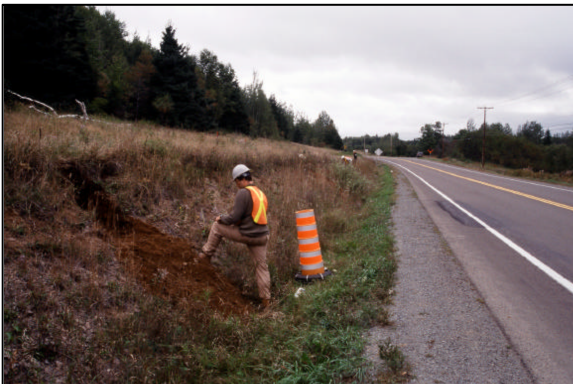
Photo 11 : Vue générale de la route 132 dans le glacis de la zone 3 (20-3174-8406-D3-20)
