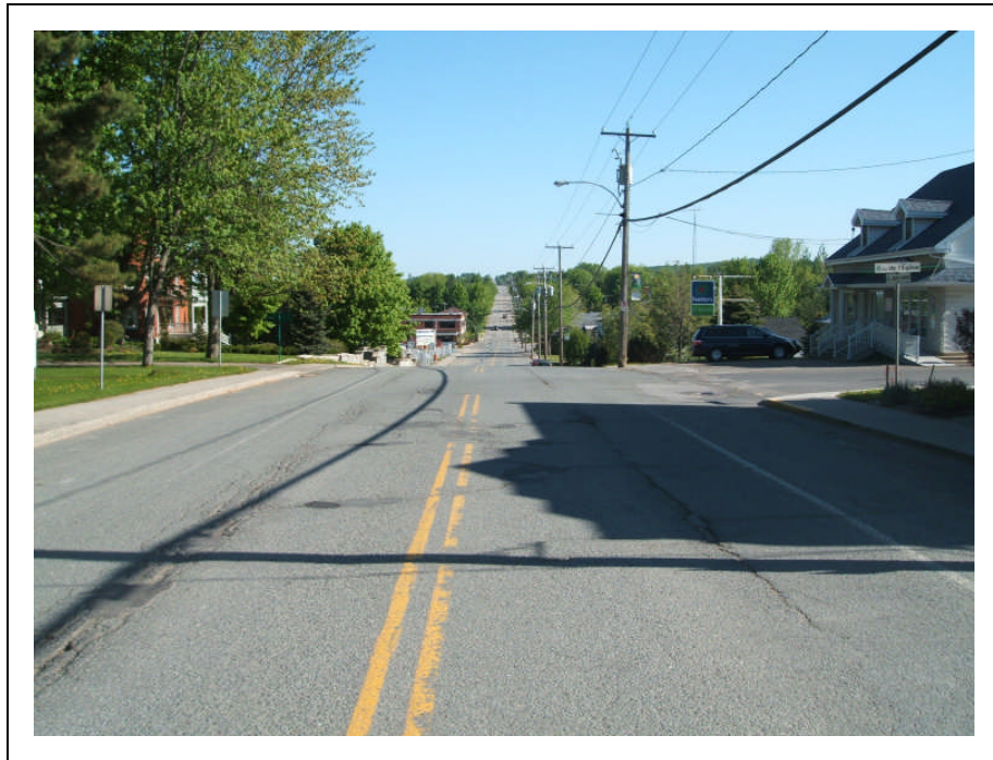
Photo 3 : Projet no. 154-05-1136, ville de Valcourt, route 222 (rue Saint-Joseph), km 0+950, environnement rue de l'Église, vers le nord (N.1-23)
