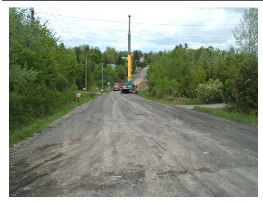
Photo 5 : Projet no. 154-91-2227, ville de Magog, chemin des Pères (chemin Bolton-est), km 5+820, secteurs 1 et 2, limite sud des travaux, vu vers le nord (N.1-01)
