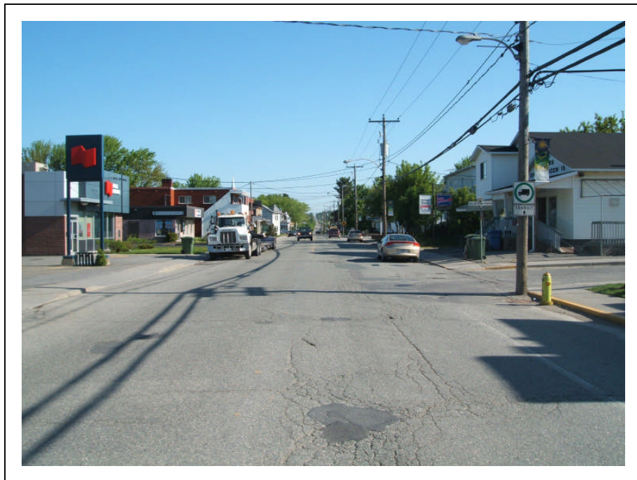
Photo 2 : Projet no. 154-05-1136, ville de Valcourt, route 222 (rue Saint-Joseph), km 0+570, environnement rue N.-D.-des-Champs, vers le nord (N.1-20)
