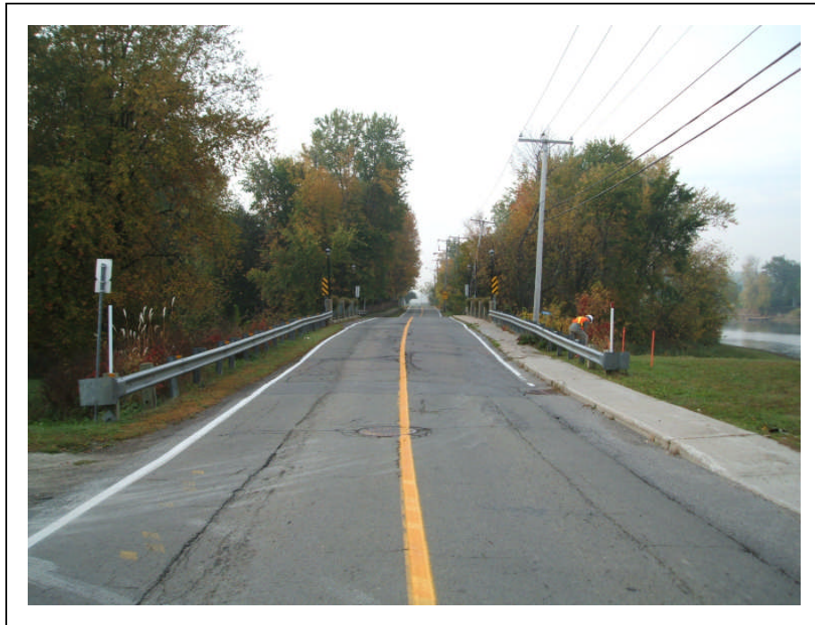
Photo 5 : Projet no. 154-94-1233, municipalité de Saint-André-d'Argenteuil, route 344, km 0+965, limite nord des secteurs 1 et 2, vers le sud (N.9-001)
