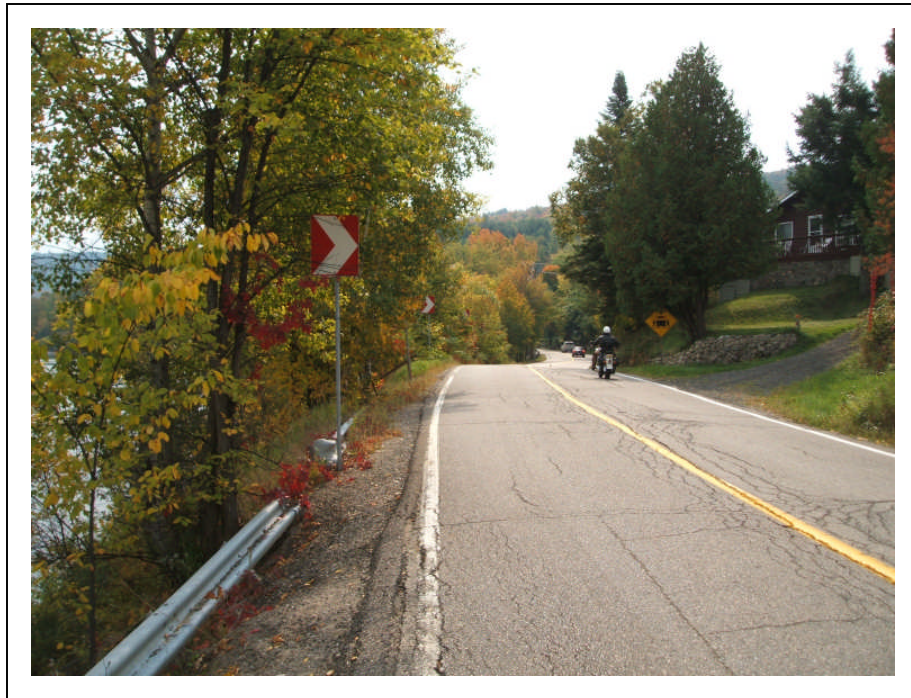
Photo 1 : Projet no. 154-05-0576, municipalité de Montcalm, route 327, km 3+685, environnement des secteurs 1 et 2, vers l'est (N.8-006)
