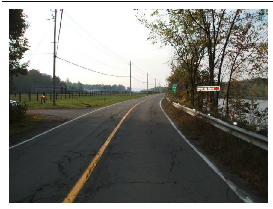
Photo 6 : Projet no. 154-94-1233, municipalité de Saint-André-d'Argenteuil, route 344, km 1+360, chemin des Châteaux dans les secteurs 1 et 2, vers le sud (N.9-016)
