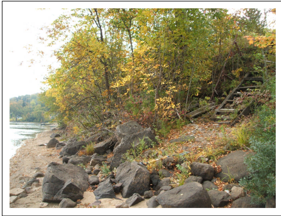
Photo 3 : Projet no. 154-05-0576, municipalité de Montcalm, route 327, km 3+660, environnement talus et escalier dans le secteur 1, vers l'est (N.8-019)
