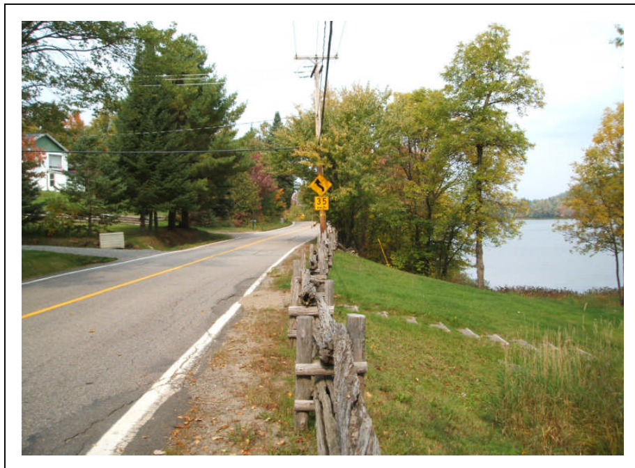
Photo 2 : Projet no. 154-05-0576, municipalité de Montcalm, route 327, km 3+790, environnement limite est du secteur 1, vers l'ouest (N.8-011)
