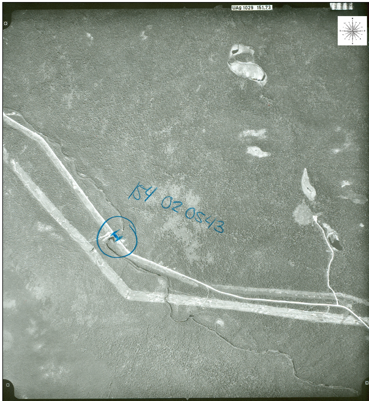
Figure 3 : Localisation du projet 154-02-0543, route 389, municipalité de Rivière-aux-Outardes (rivière Quicaquestagane) sur photo aérienne (Q8859-132 au 1:15 000, source : Photocartotheque du Québec).
