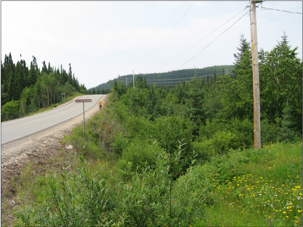
photo 1 : Projet 154-02-0543, vue générale du côté nord-ouest de la route 389 depuis l'extrémité nord-est de l'emprise, municipalité de Rivière-aux-Outardes (rivière Quicaquestagane). Direction ouest (photo 154-02-0543 #1).
