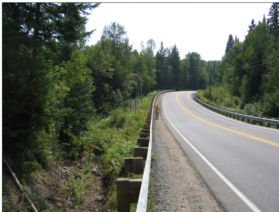
Photo 2 : Projet 154-01-0562, vue générale côté sud-ouest du chemin Saint-Joseph, municipalité de Trois-Rives. Direction ouest (photo 154-01-0562 #2).
