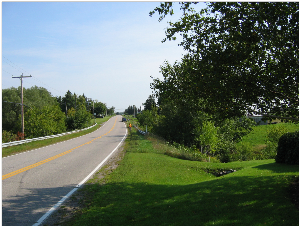
Photo 3 : Projet 154-06-1976, vue générale de l'emprise du côté sud de la route 159, municipalité de Saint-Prosper. Direction est (photo 154-06-1976 #3).
