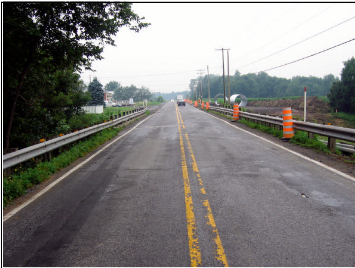
Photo 12 : L'aire des travaux, route 132, municipalité de Yamaska, direction est (20-5372-9213-06-NUM1-2).
