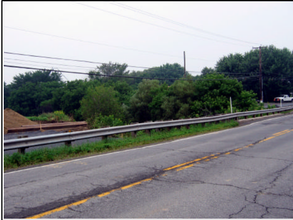
Photo 10 : Aménagement d'une voie de contournement dans l'axe de l'ancien tracé de la route 132, municipalité de Yamaska, direction sud-est (20-5372-9114-06-NUM1-7).
