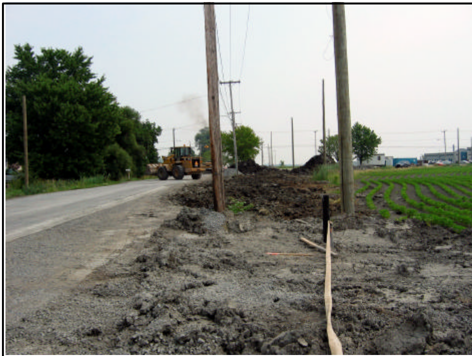
Photo 3 : Travaux en cours, secteur 1, angle sud-ouest de l'intersection de la route 229 et du chemin Trudeau, municipalité de Saint-Mathieu-de-Beloeil, direction est (20-5371-02D4-X2-06-NUM1-4).
