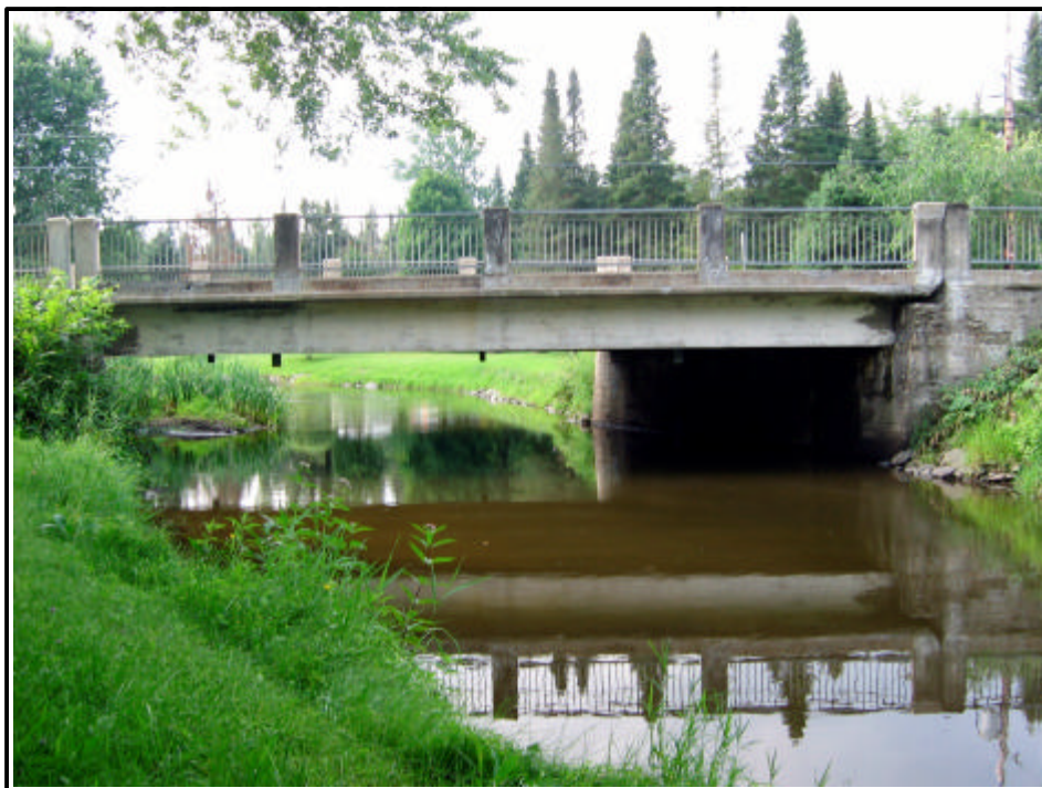
Photo 14 : Ponceau de la rivière Yamaska nord, chemin du 8 e Rang ouest, municipalité de Saint-Joachim-de-Shefford, direction sud (20-5373-9915-06-NUM1-9).
