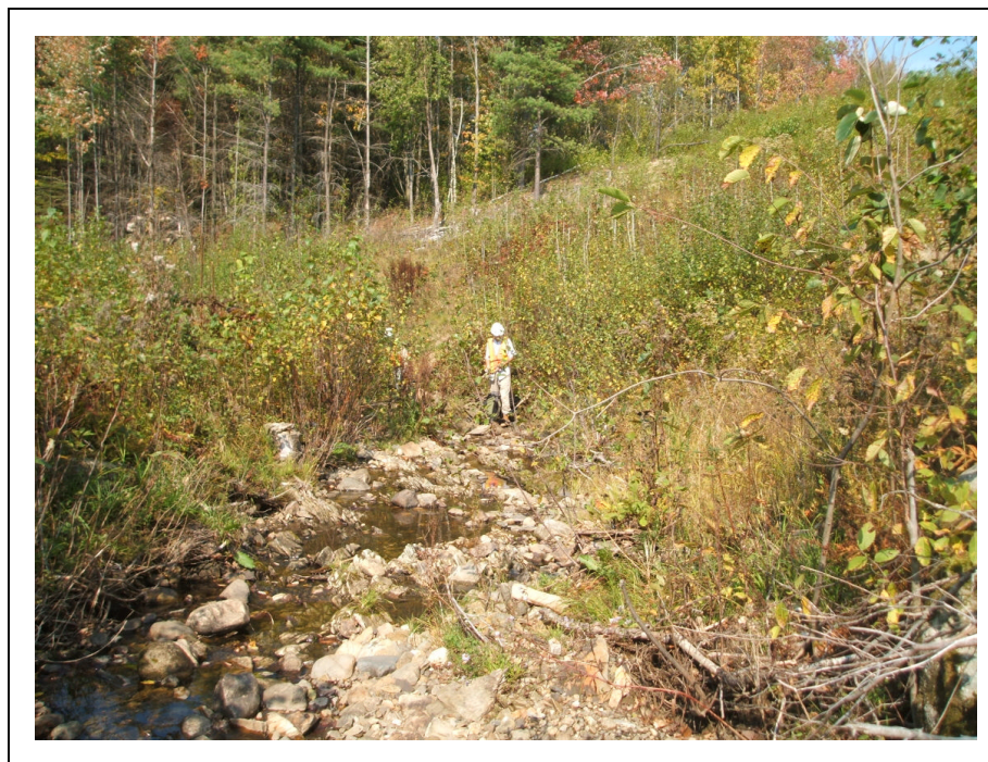
Photo 3 : (N.1-014) secteur 1, route 108, Sainte-Catherine-de-Hatley, km 6+100, vu vers l'ouest, inspection visuelle
