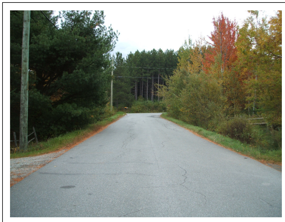
Photo 7 : (N.1-025) secteur 3, route 108, Sainte-Catherine-de-Hatley, km 0+040, vu vers l'est, fin du projet
