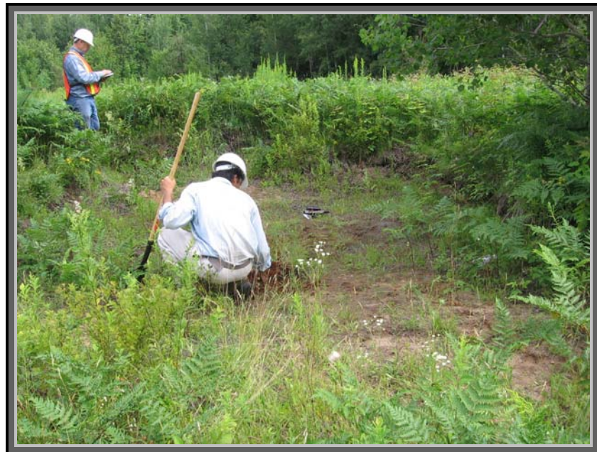
Photo 2 : Secteur 4, vue générale de l'environnement et d'un remblai de terrassement (MTQ-L2-01)
