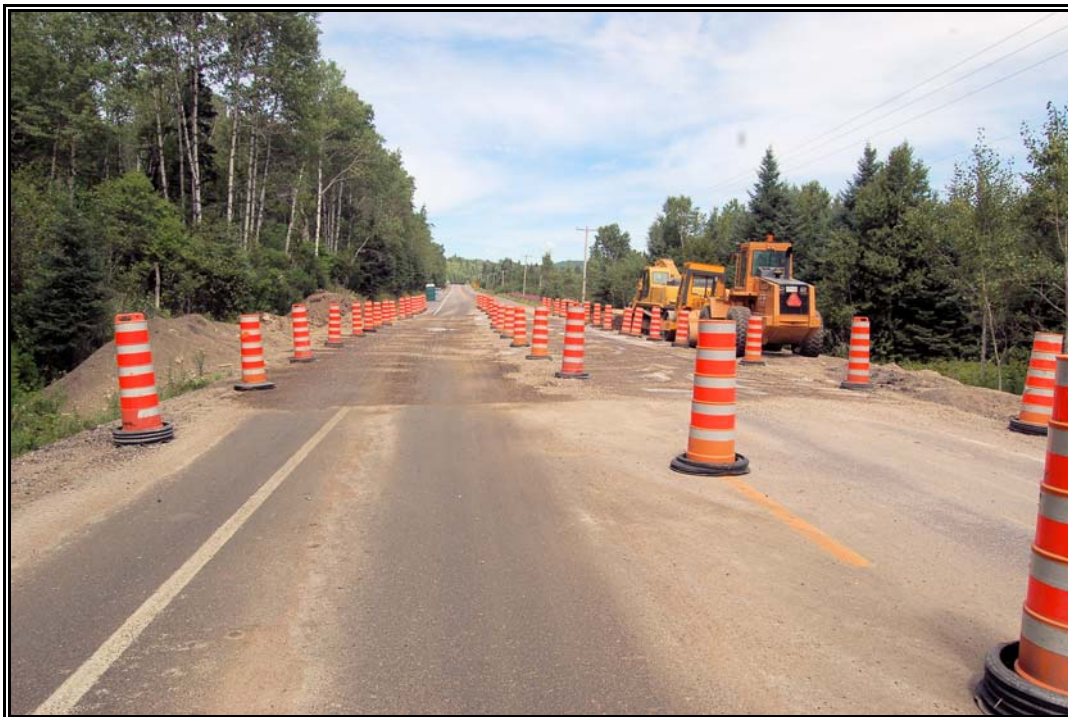
Photo 8 Projet n° 154-06-0966, environnement général du secteur inventorié (km 1 + 080), municipalité de La Bostonnais, direction nord (PATR07N07-22).
