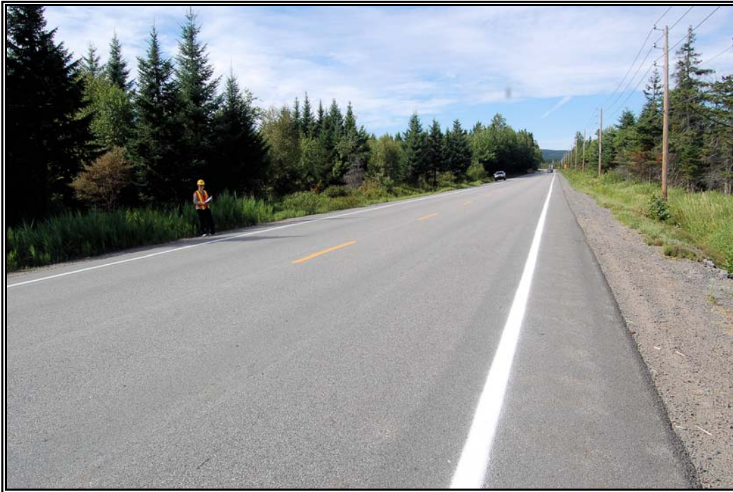
Photo 3 Projet n° 154-06-0624, environnement général du secteur inventorié (km 2 + 290), municipalité de Grandes-Piles, direction nord (PATR07N07-28).
