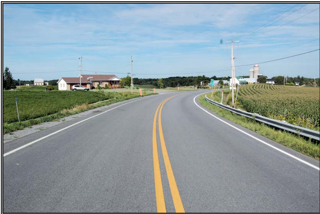
Photo 12 Projet n° 154-06-1481, environnement général du secteur 4 (ponceau n° 0940-0) (km 0 + 000), municipalité de Saint-Prosper, direction nord-nord-ouest (PATR07N07-13).
