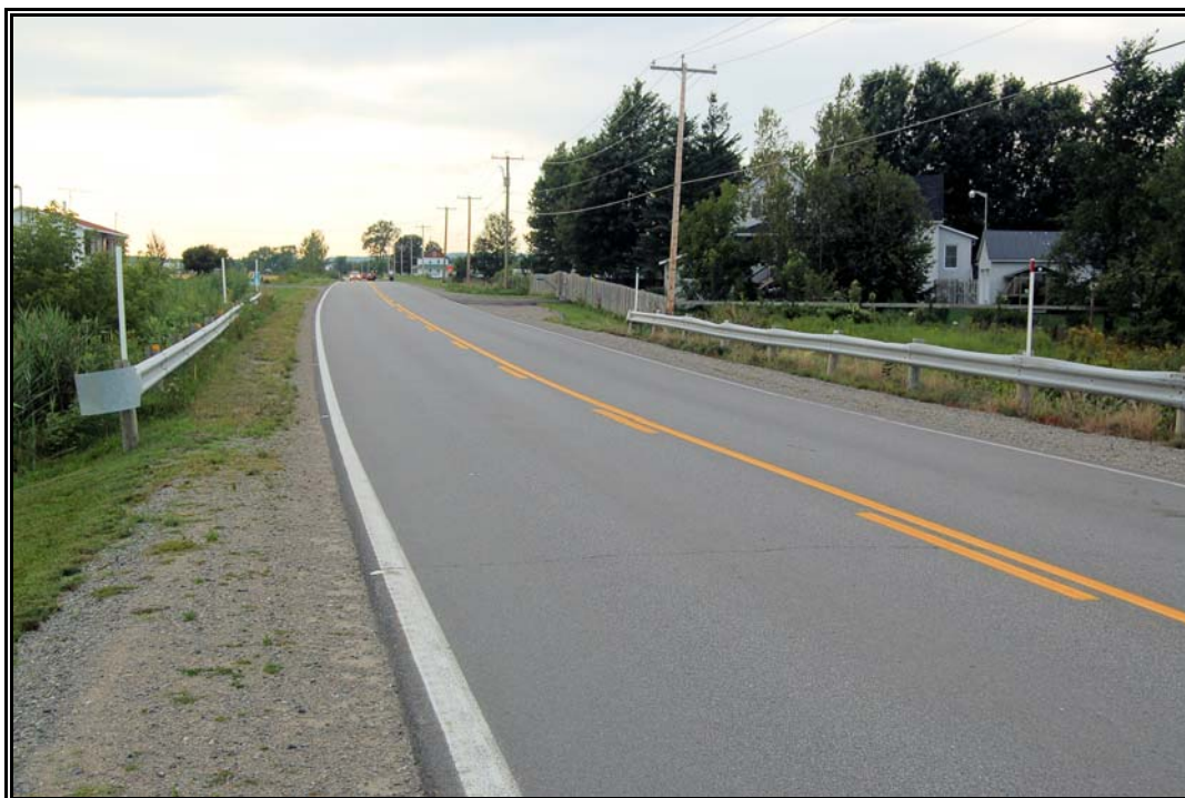
Photo 5 Projet n° 154-06-0674, environnement général du secteur inventorié (km 5 + 320), municipalité de Sainte-Ursule, direction ouest (PATR07N07-25).
