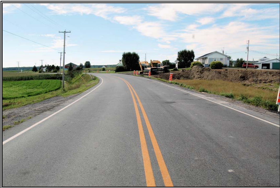
Photo 11 Projet n° 154-06-1481, environnement général du secteur 3 (ponceau n° 0939-0) (km 0 + 000), municipalité de Saint-Prosper, direction nord-ouest (PATR07N07-16).
