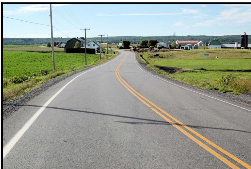
Photo 10 Projet n° 154-06-1481, environnement général du secteur 2 (ponceau n° 0938-0) (km 0 + 000), municipalité de Saint-Prosper, direction nord-ouest (PATR07N07-19).
