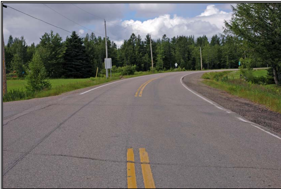
Photo 2 Projet n° 154-06-0619, environnement général du secteur 2 (ponceau n° 1113-0) (km 0 + 000), municipalité de Saint-Léon-le-Grand, direction nord (PATR07N07-4).
