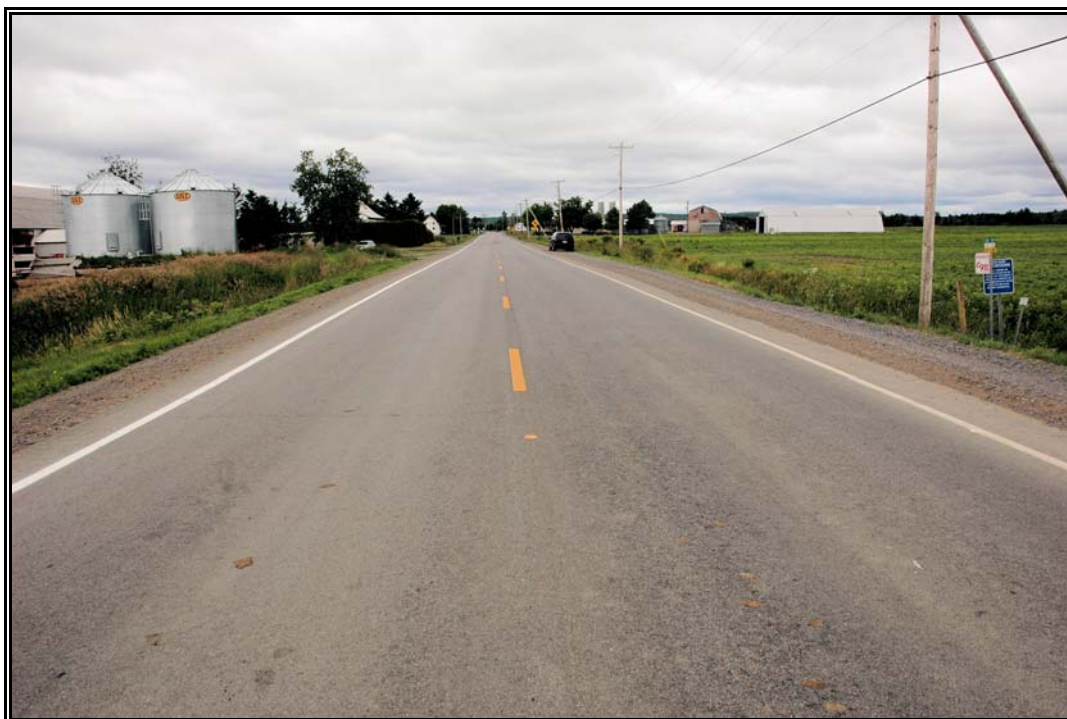
Photo 9 Projet n° 154-06-1481, environnement général du secteur 1 (ponceau n°0932-0) (km 0 + 000), municipalité de Saint-Prosper, direction nord (PATR07N07-8).
