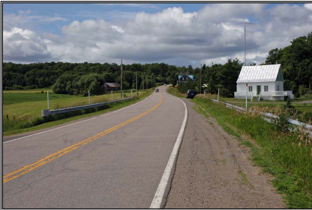
Photo 1 Projet n° 154-06-0619, environnement général du secteur 1 (ponceau n° 1109-0) (km 1 + 080), municipalité de Saint-Léon-le-Grand, direction nord (PATR07N07-2).
