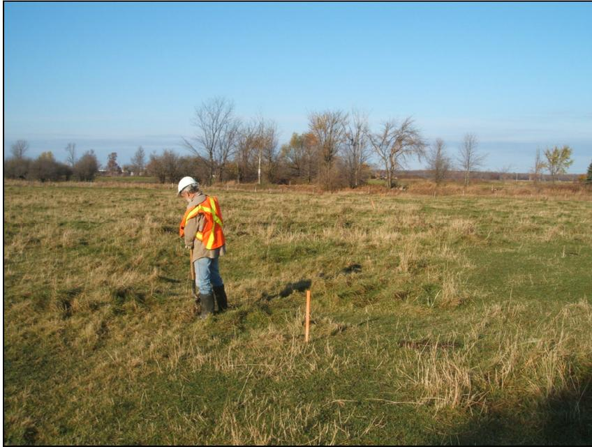
**Photo 17 :** (N.11-014) secteur 11, km 3+520, vu vers l'ouest, réalisation de sondages
