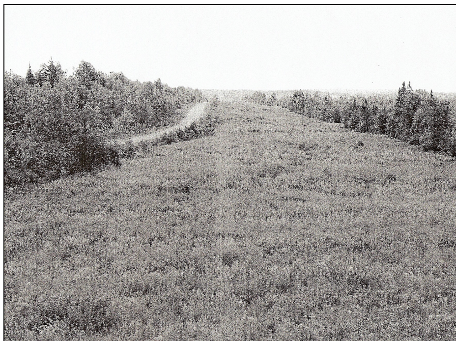
Photo 2: Emprise de la future voie est de l'autoroute 55, à la hauteur de la municipalité de l'Avenir, secteur « E », du km 30+000 au km 31+600, vers le sud (DSCF0140)
