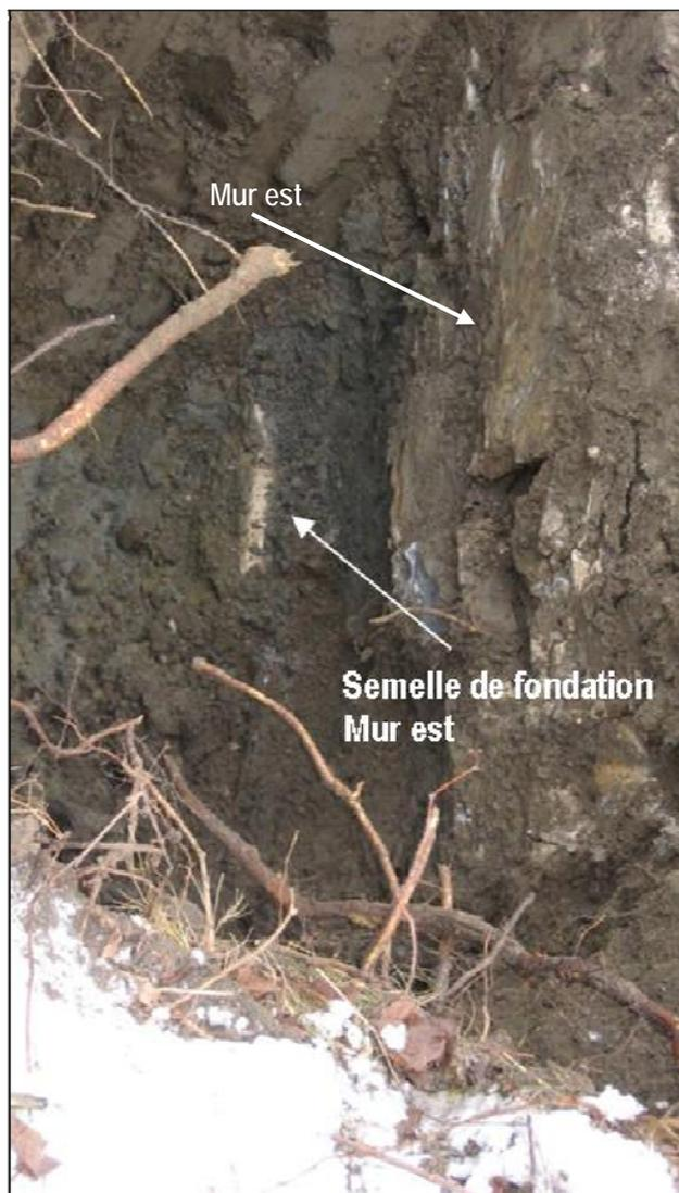
**Photo 75** Aqueduc n° 3, semelle de fondation du mur est de la sortie nord dans le secteur 18, en direction sud (zone 9), (PATR08N11-223)
