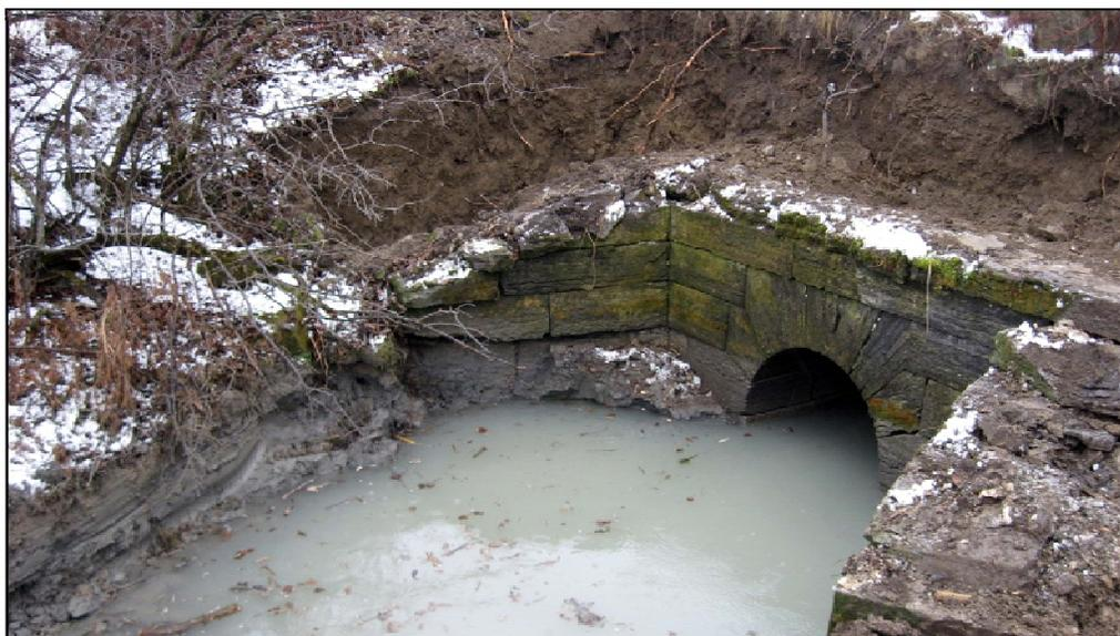
**Photo 74** Aqueduc n° 3, les pierres supérieures des murs en ailes ont été taillées en diagonale, sortie nord dans le secteur 18 (zone 9), en direction sud-est (PATR08N11-233 et 234)
