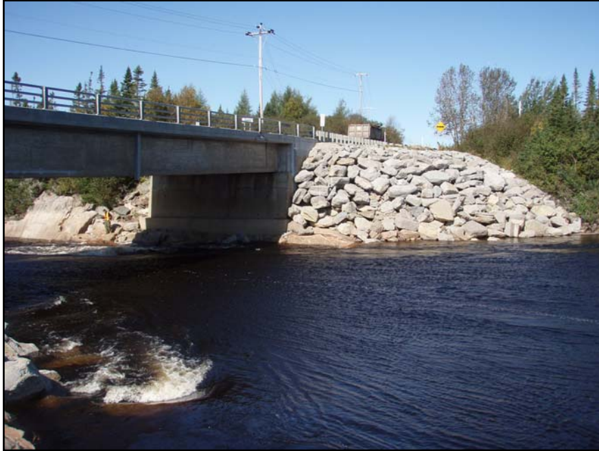
Photo 6 : Enrochement de la culée ouest du pont de la rivière Romaine, km 2 + 640, direction sud-ouest (154-00-0387-08-NUM1-43)
