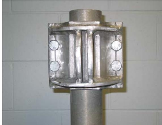
Zone d'assemblage où la plaque d'ancrage de la diagonale RT s'insère entre les goussets de la bride afin d'y être boulonnée.
