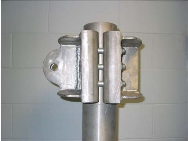
Vue de profil d'une bride installée sur un longeron de 127 mm D.E. pour poutres B et T2. Le même type de bride est utilisé pour les poutres C et T3.
