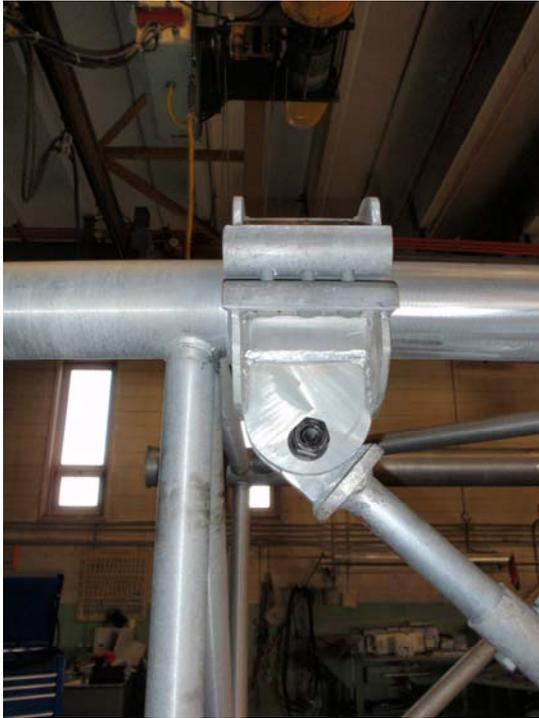
Bride de type 2 installée sur le longeron supérieur d'une poutre T3 – Longeron 152 mm D.E.
