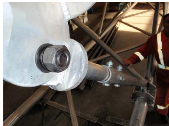
Vue d'ensemble d'une diagonale de renfort télescopique (RT).
