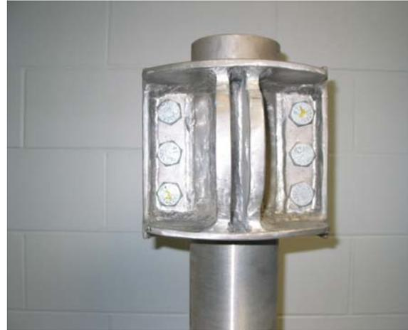
Zone d'assemblage où la plaque d'ancrage de la diagonale RT s'insère entre les goussets de la bride afin d'y être boulonnée.
