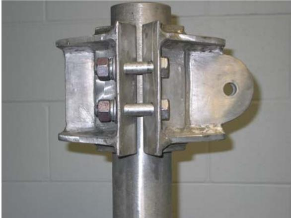
Vue de profil d'une bride installée sur un longeron de 89 mm D.E. pour poutres A et T1.
