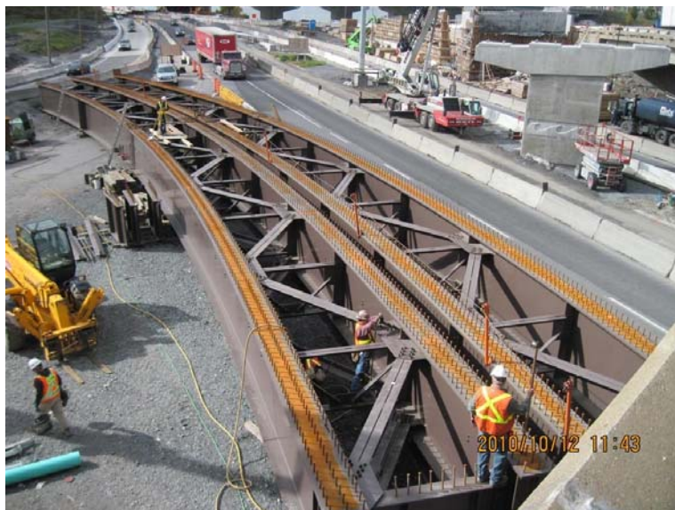
Figure 22. Pré-assemblage au sol des sections de paires de poutres.
