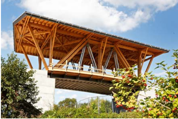
1 er pont « privé » en bois, en France. 2010 Scierie SIAT-BRAUN à Urmatt. Tout véhicules, 70 tonnes, portée 17 m, sapin massif local, pont à poutre treillis. Ce pont surplombe la voie SNCF
