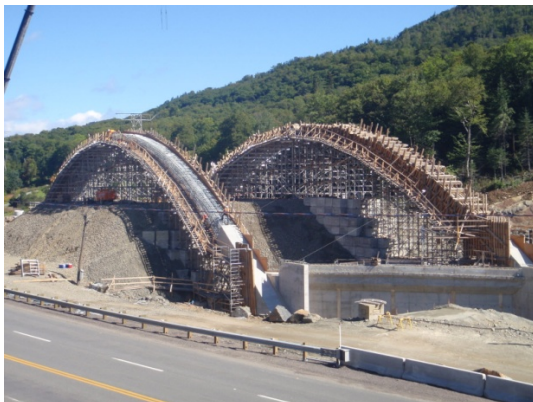
Figure 7 - Photos des étalements et coffrage des arcs
