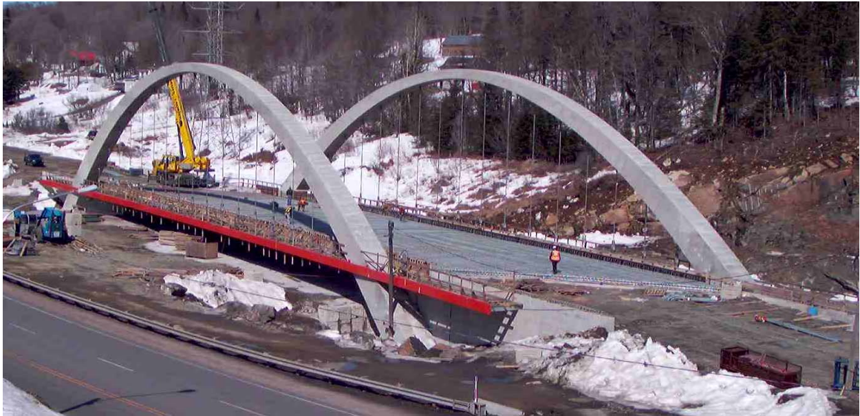
Figure 9 - Vue d'ensemble du pont avant le bétonnage de la dalle
