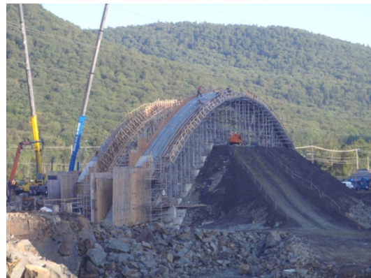
Figure 7 - Photos des étalements et coffrage des arcs
