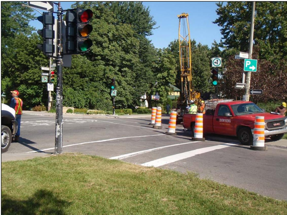
Photo 3 : Forage n° 5 (MTL08-01-1-1B) en cours de réalisation, angle sud-est de l'intersection du boulevard Gouin et de l'avenue Papineau, direction nord-est (154-96-0690-08-NUM1-4)
