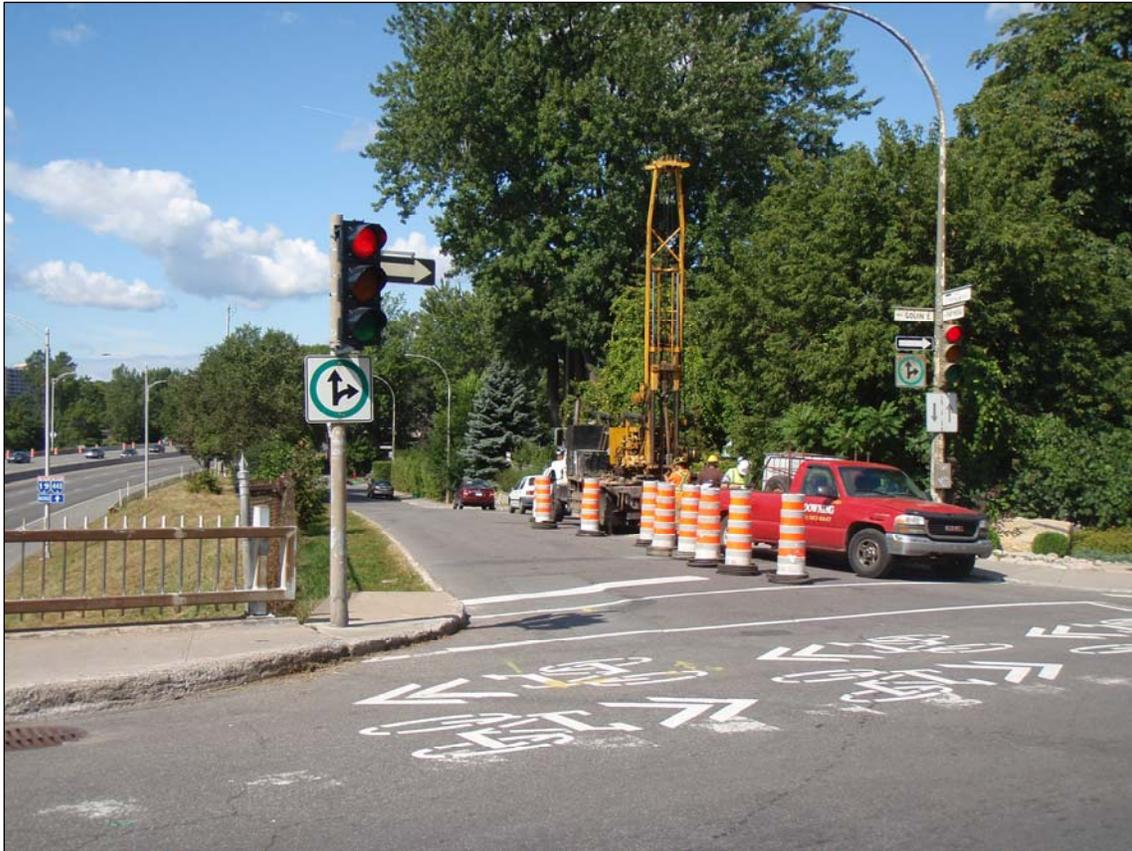
Photo 2 : Forage n° 4 (MTL08-01-1-1A) en cours de réalisation, angle nord-est de l'intersection du boulevard Gouin et de l'avenue Papineau, direction nord-est (154-96-0690-08-NUM1-8)
